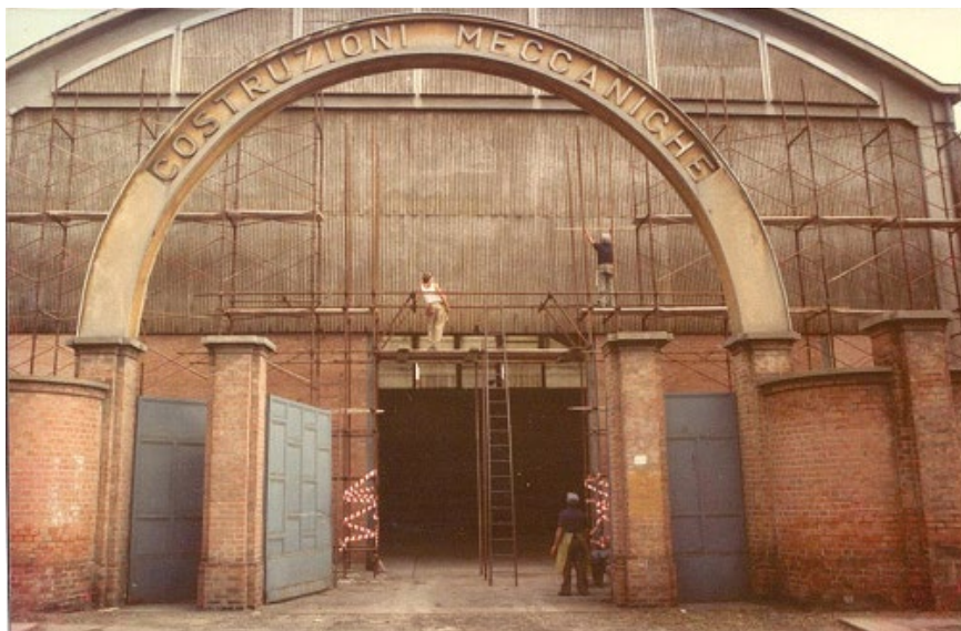
Fig 4.2.1.13 Facciata principale su via Palermo, prima dei lavori di recupero (1984).._ Archivio dell'Ufficio Tecnico dell'Università di Parma
