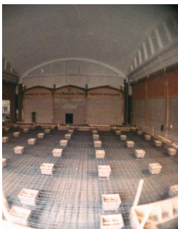
Fig 4.3.12 Platea di fondazione in corso d'opera
