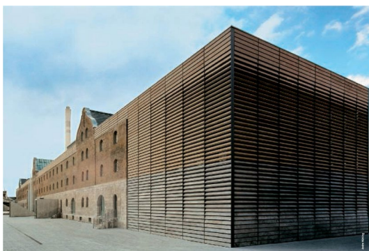
Fig. 1.6.1.4 Vista esterna con in evidenza le addizioni laterali rivestite in lamelle di pietra, foto di Andre Mühlring, "Scatole per l'arte", Arketipo 20, Gennaio-Febbraio 2008_p85
