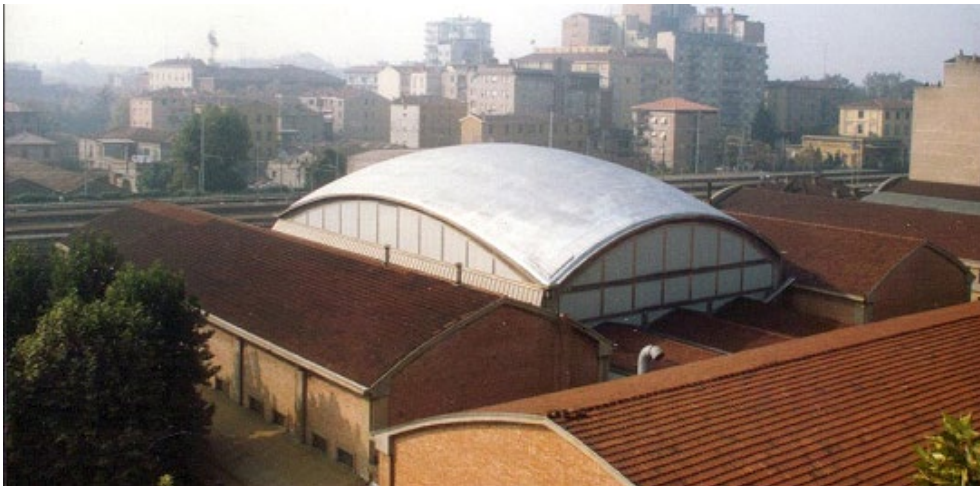
Fig 4.2.1.12 Vista esterna della volta del padiglione Nervi, 1984.
