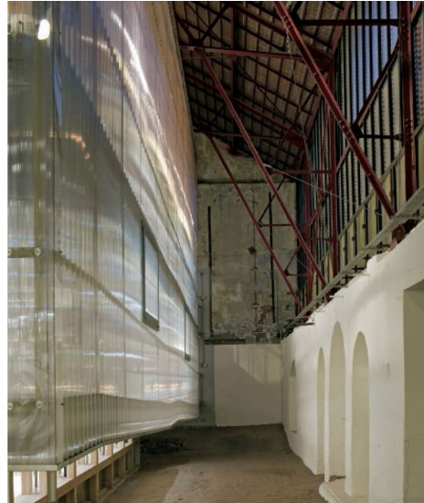
Fig. 1.6.1.6 Vista laterale dell'involucro di policarbonato all'interno della vecchia fabbrica, Foto di Paul Raftery-VIEW, "Riflessi di cristallo", Arketipo 20, Gennaio-Febbraio 2008_p51
