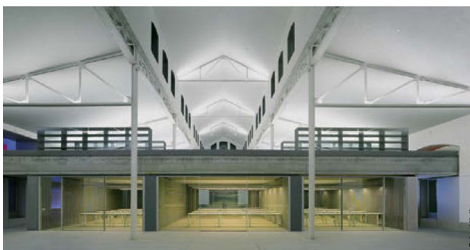
Fig 1.8.1.9 Le fasi di recupero. Le travi ponte permettono la creazione di due livelli e la possibilità di chiudere alcune aule studio. Arketipo 77, settembre 2013_ p.135
