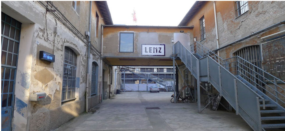
Fig 3.2.3.2.1 Ingresso al Lenz. Dal sito: lenzifrazioni.it
