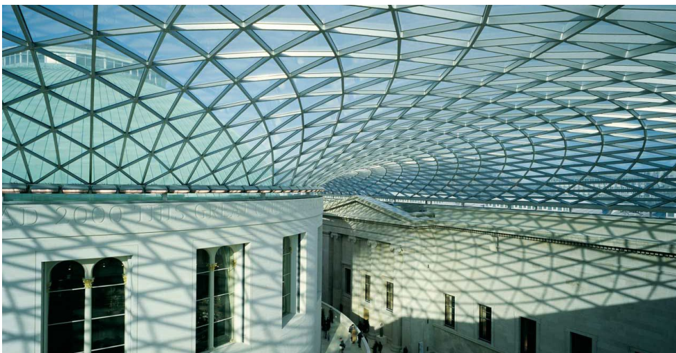
Fig.1.6.1.9 Vista dell'atrio vetrato che collega la sala di lettura e l'edificio preesistente, Immagine tratta dal sito: www.fosterandpartners.com
