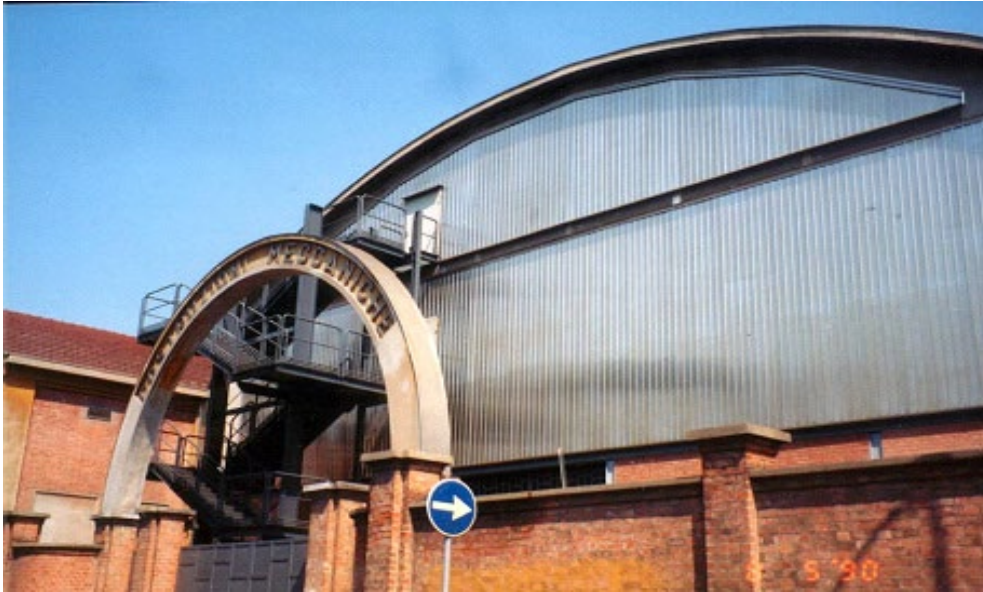
Fig 4.3.6 Vista facciata principale su via Palermo, dopo dell'intervento di recupero, (1990)._ Archivio Ufficio Tecnico – Università degli Studi di Parma
