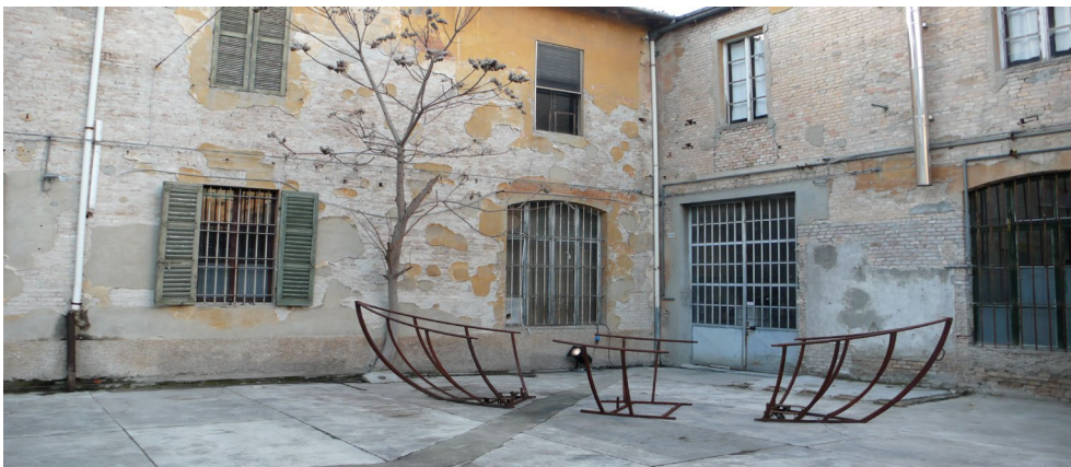
Fig 3.2.3.2.2 Cortile principale. Dal sito: lenzifrazioni.it
