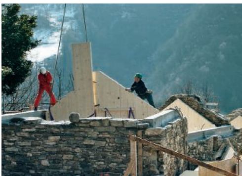
Fig. 1.6.3.3 Posa dei pannelli prefabbricati autoportanti, Foto studio Arnaboldi, Arketipo 10, Gennaio-Febbraio 2007_p58
