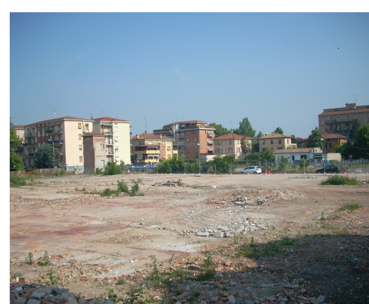
4_Area demolita per la realizzazione della Stu Stazione
