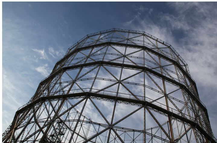
Immagine 4.23 Gasometro del quartiere Bovisa, identificativo dell'area.
