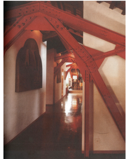
Particolare delle capriate in ferro inserite in un appartamento a Venezia [Fonte: Scevola A., Rosanna Monzini: la casa alla milanese, Abitare Segesta, Milano, 2005]
