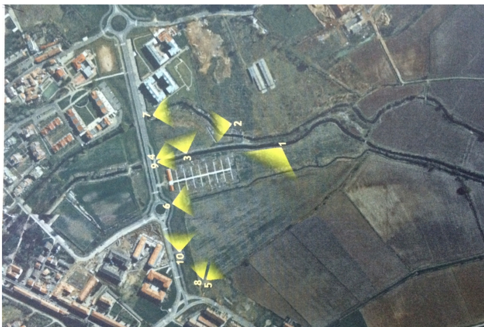
Fig. 5.2.1 Area oggetto dell'intervento. (immagine scannerizzata dalla documentazione in archivio presso la regione Lombardia del PII relativo).
