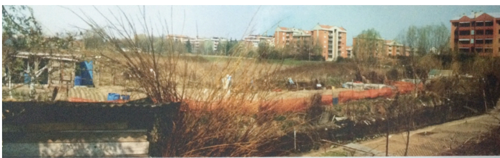
Fig. 5.2.2 Stato di fatto dell'area oggetto dell'intervento. (immagine scannerizzata dalla documentazione in archivio presso la regione Lombardia del PII relativo)
