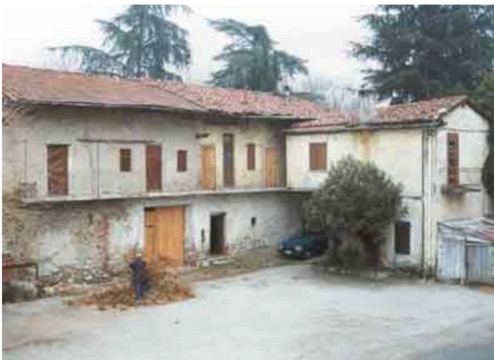
Fig. 5.13.4 Cascine del Quiquo stato di fatto prima dell'intervento (immagine da archivio Regione Lombardia)
