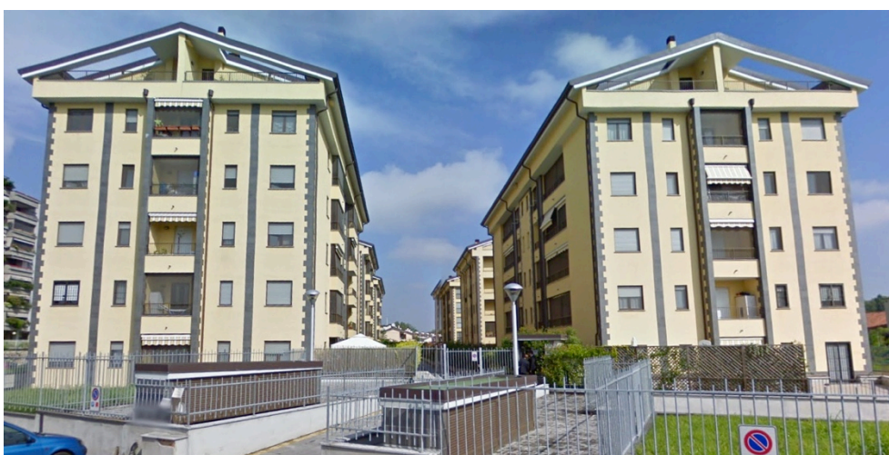
Fig. 5.5.4 Nuovo plesso residenziale frazione di Valleambrosia, Rozzano (immagine da archivio Regione Lombardia)
