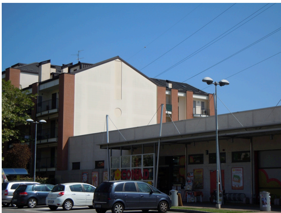
Fig. 5.7.12 Complesso residenziale e commerciale Via Boccaccio (immagine da archivio Regione Lombardia).
