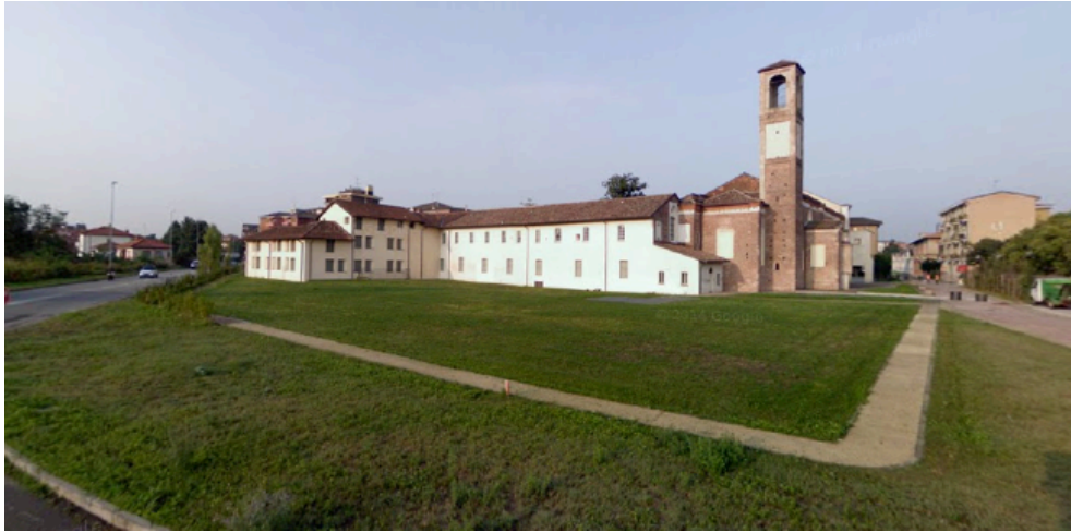
Fig. 5.1.11 Convento dell'Annunciata. Le opere oggetto di PII sono state realizzate in una parte retrostante il Convento. (immagine da Google Maps).
