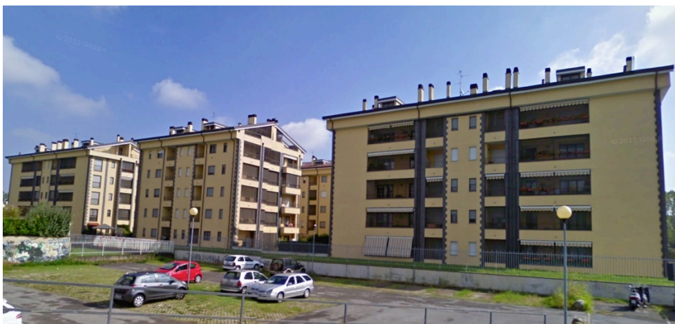
Fig. 5.5.5 Nuovo plesso residenziale frazione di Valleambrosia, Rozzano (immagine da archivio Regione Lombardia).
