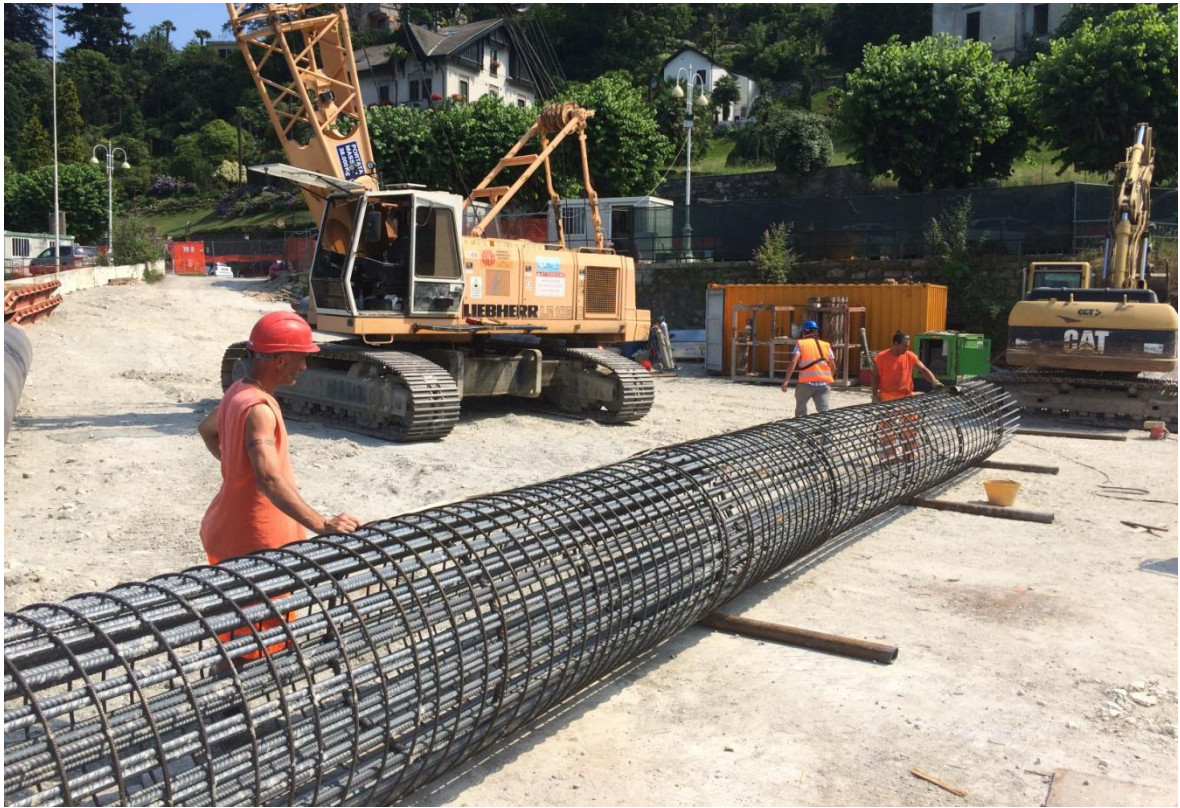
Figura 37 - Esempio armatura di un palo
