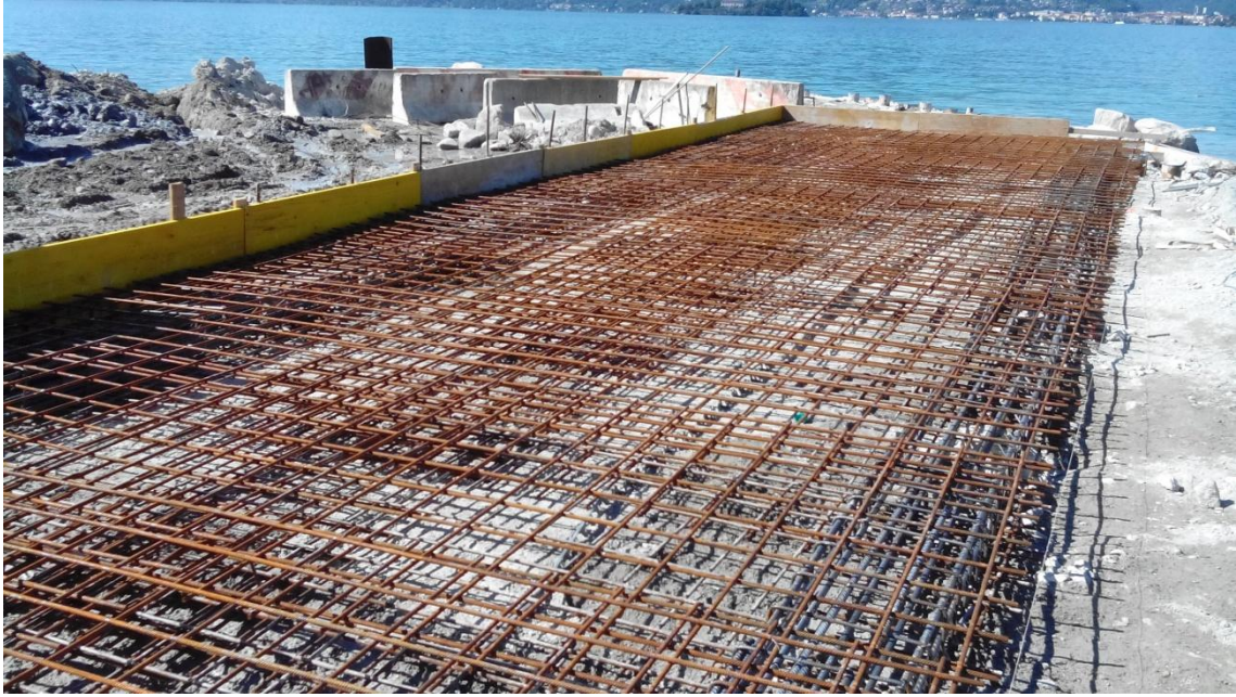
Figura 18 - Gabbia di armatura per la platea
