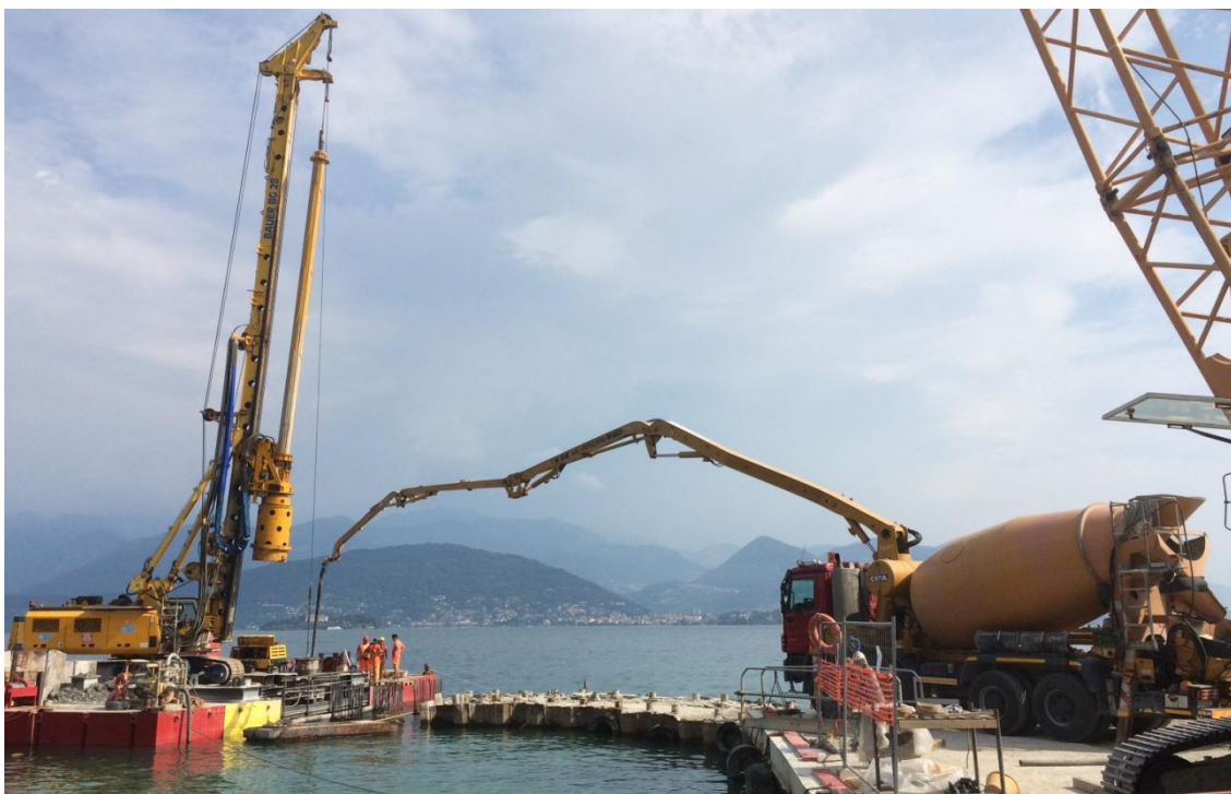
Figura 48 - Getto cls con autopompa
