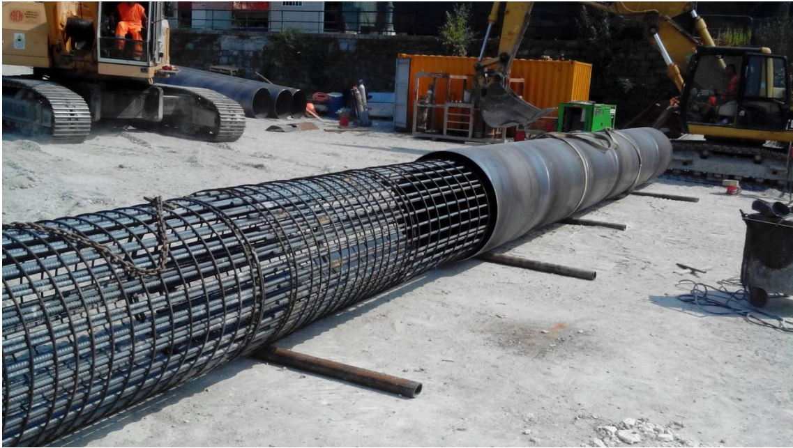
Figura 38 - Movimentazione armatura + lamierino
