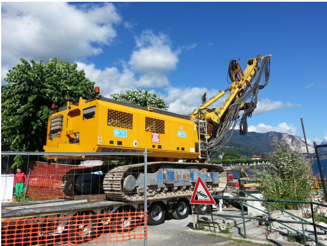
Figura 31 - Trasporto macchina perforatrice in cantiere
