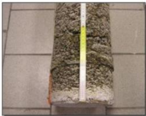
Figura 51 - Calcestruzzo gettato con un battente d'acqua di 80 cm senza additivi antilavamento.
