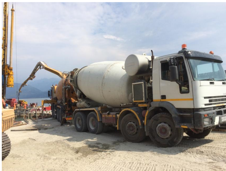
Figura 49 - Betoniera di rifornimento
