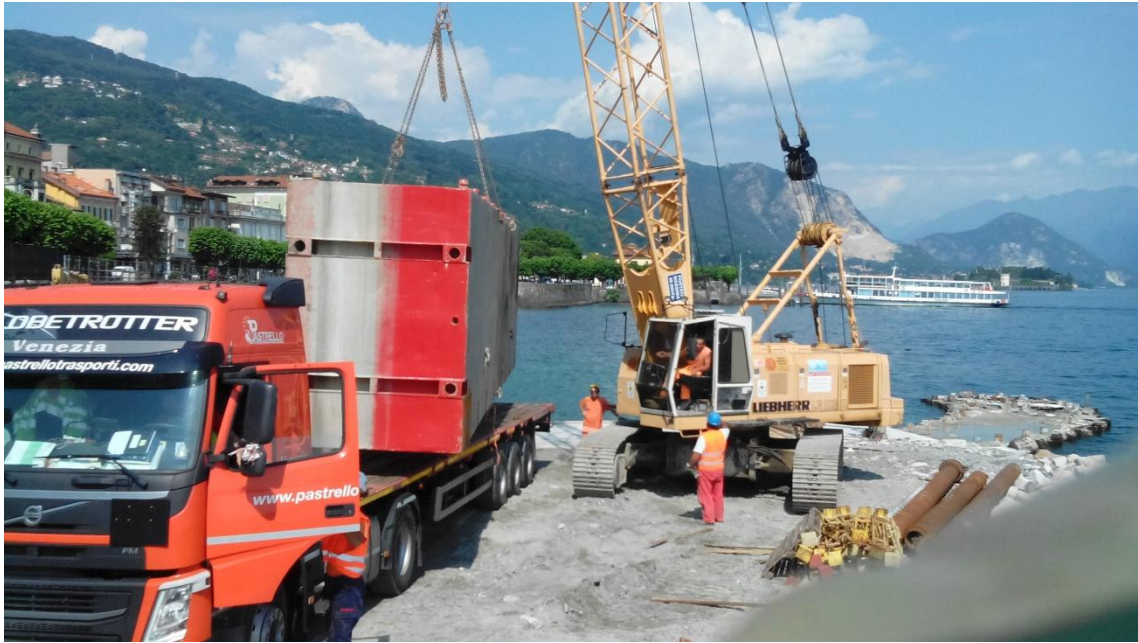
Figura 27 - Scarico moduli pontone
