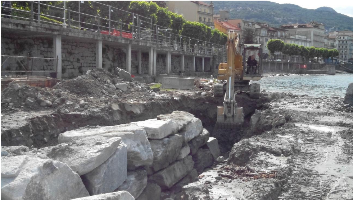
Figura 13 - Scavo e posa materiale roccioso per scogliera
