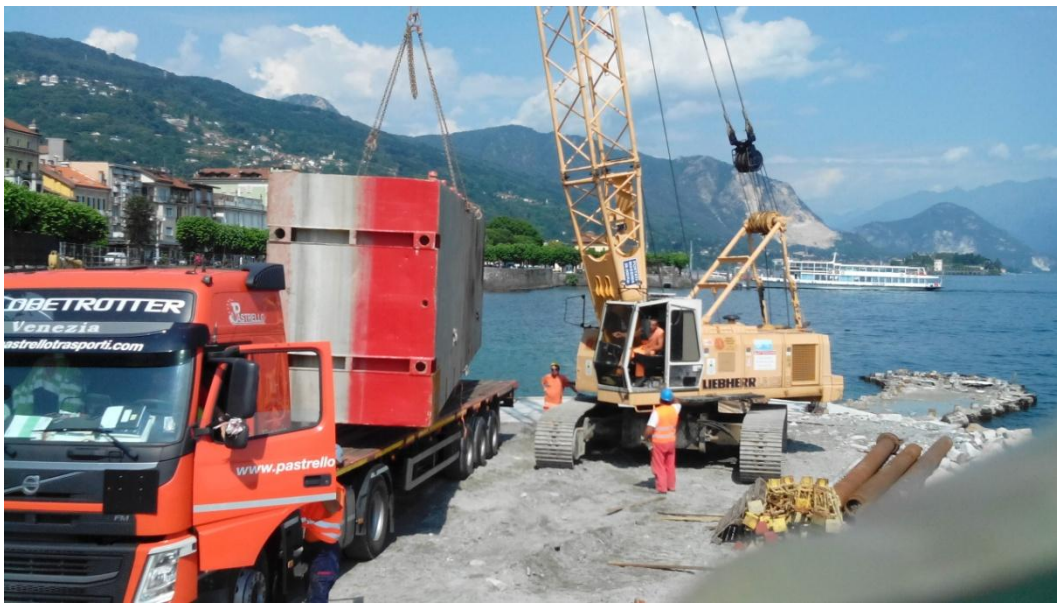
Figura 5 – Scarico pezzi Pontone
