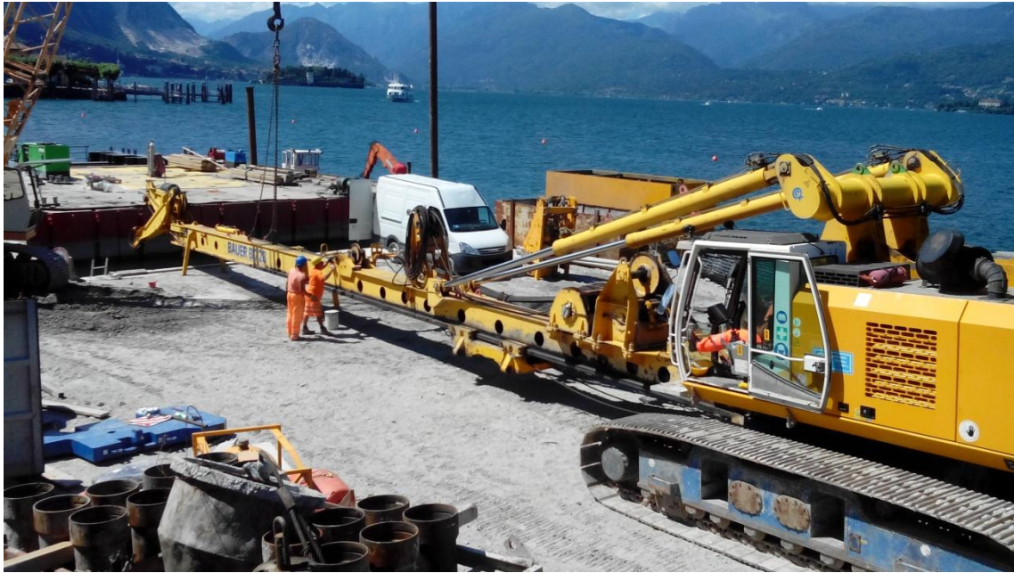
Figura 34 - Assemblaggio braccio Bauer BG28
