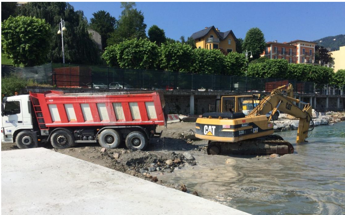
Figura 14 - Fase operativa di scavo fondale quota 192 m.s.l.m.
