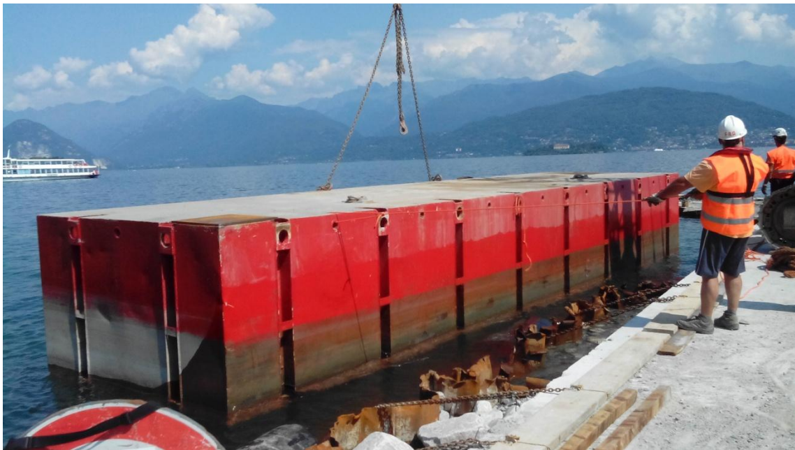
Figura 28 - Movimentazione moduli pontone in acqua
