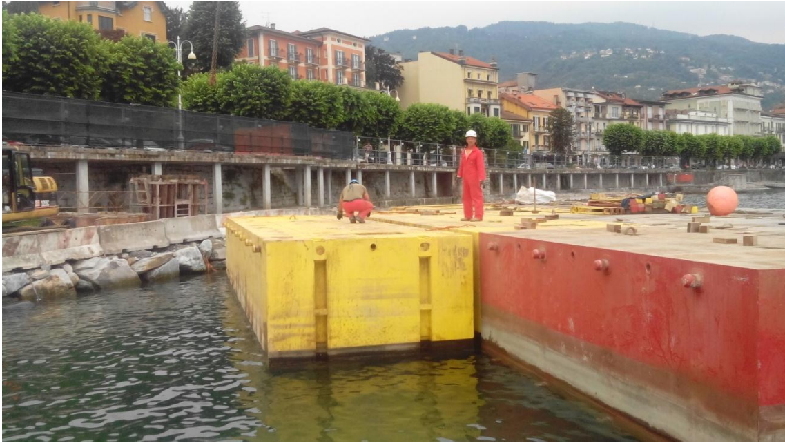
Figura 29 - Assemblaggio pontone
