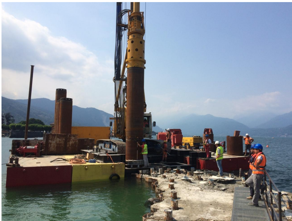
Figura 41 - Fase di scavo con posizionamento della camicia
