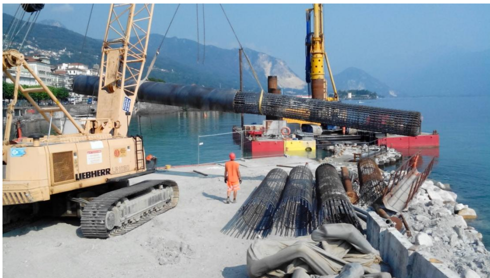
Figura 46 - Movimentazione armatura
