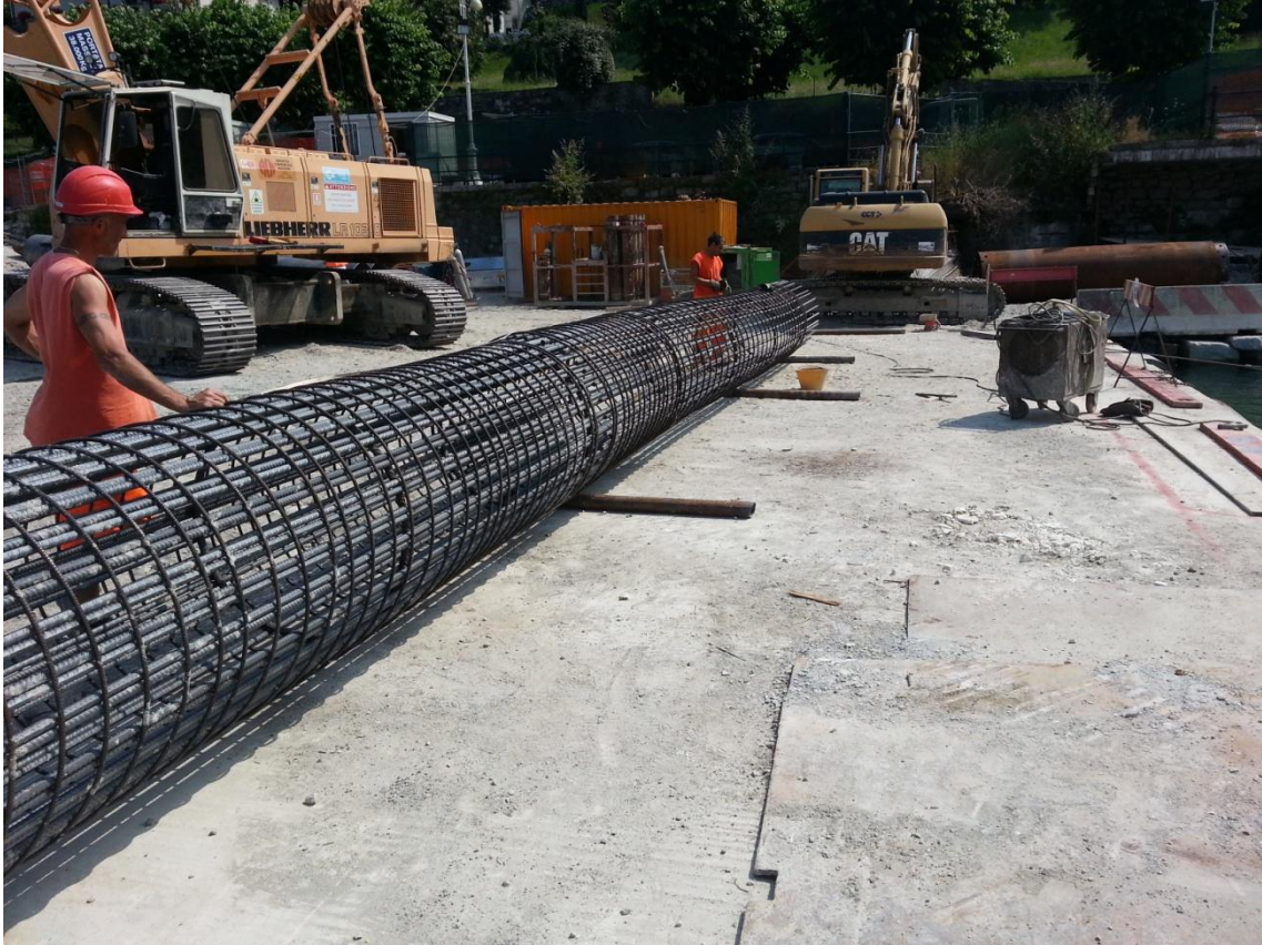
Figura 9 - Assemblaggio gabbia di armatura
