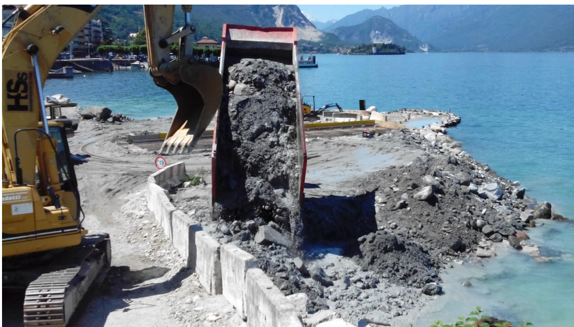
Figura 16 - Scarico materiale di scavo per creazione rilevato
