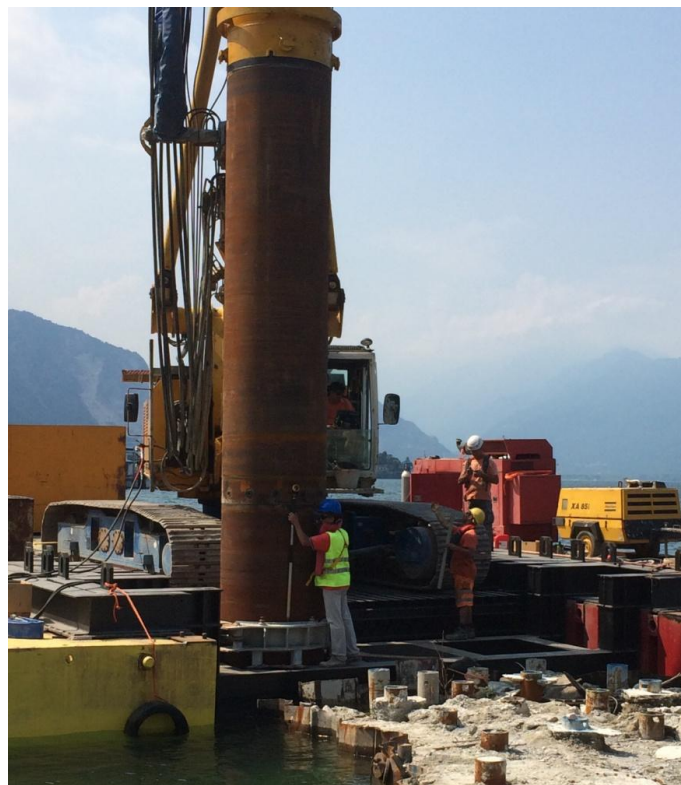
Figura 40 - Verifica del corretto posizionamento del punto di scavo
