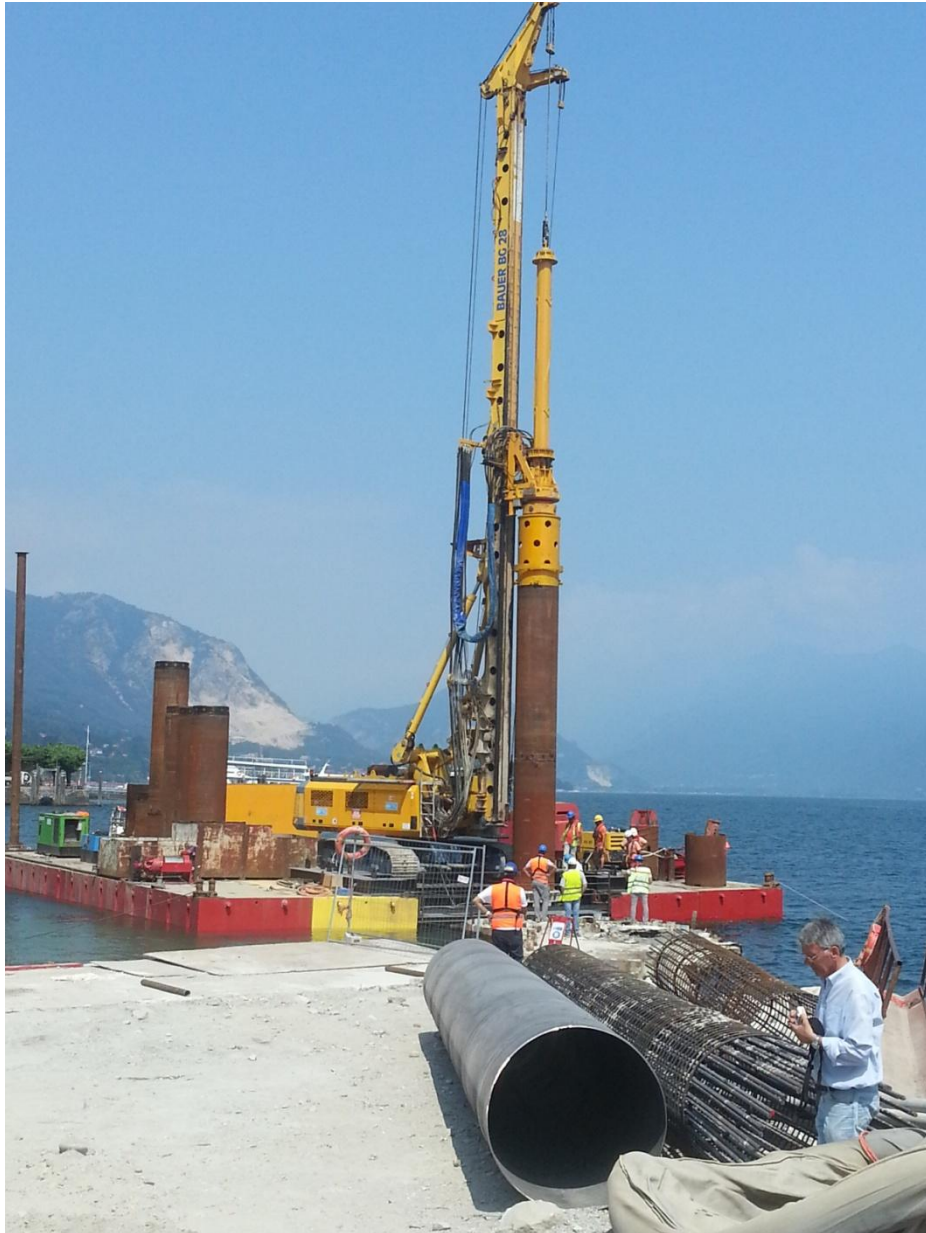
Figura 8 - Vista della fase di trivellazione
