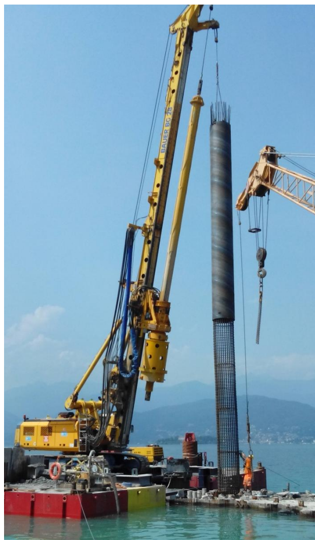
Figura 46 - Movimentazione armatura
