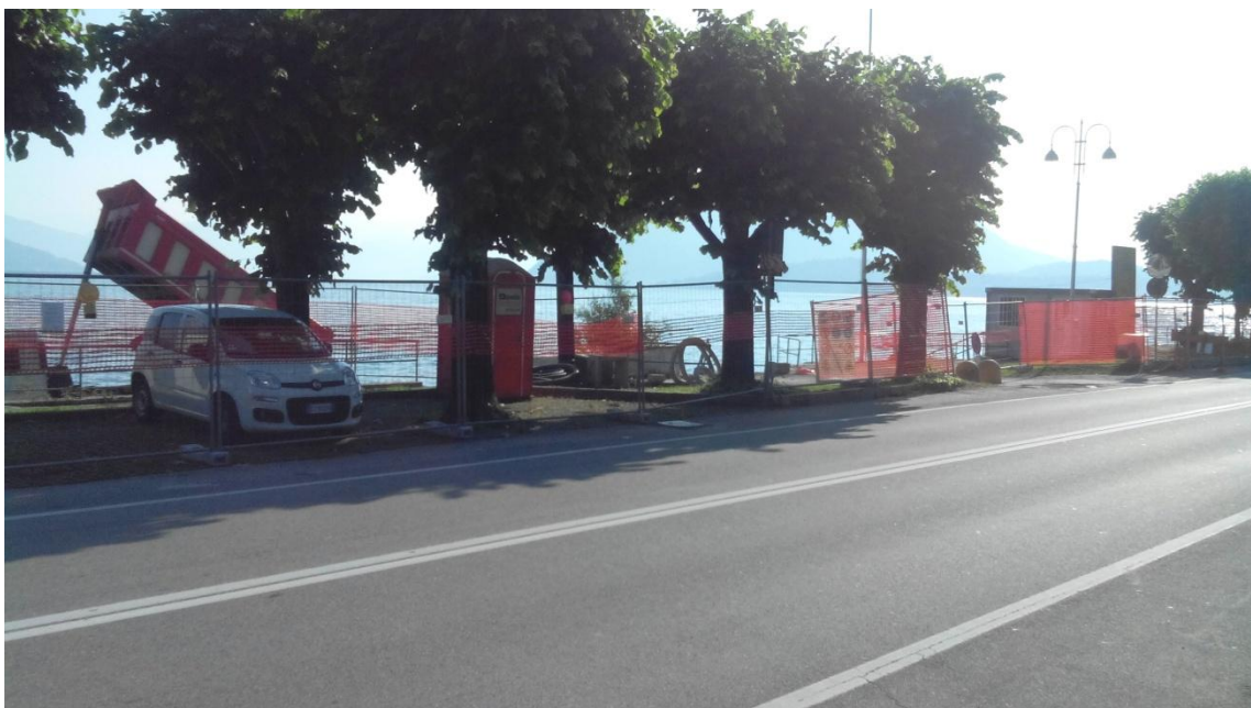
Figura 3 - Vista del cantiere
