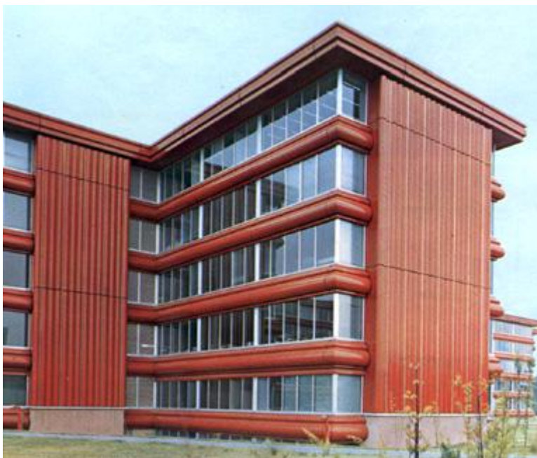
Figura 25 – Esempio di integrazione di impianti in facciata - Edificio SNAM a San Donato Milanese
