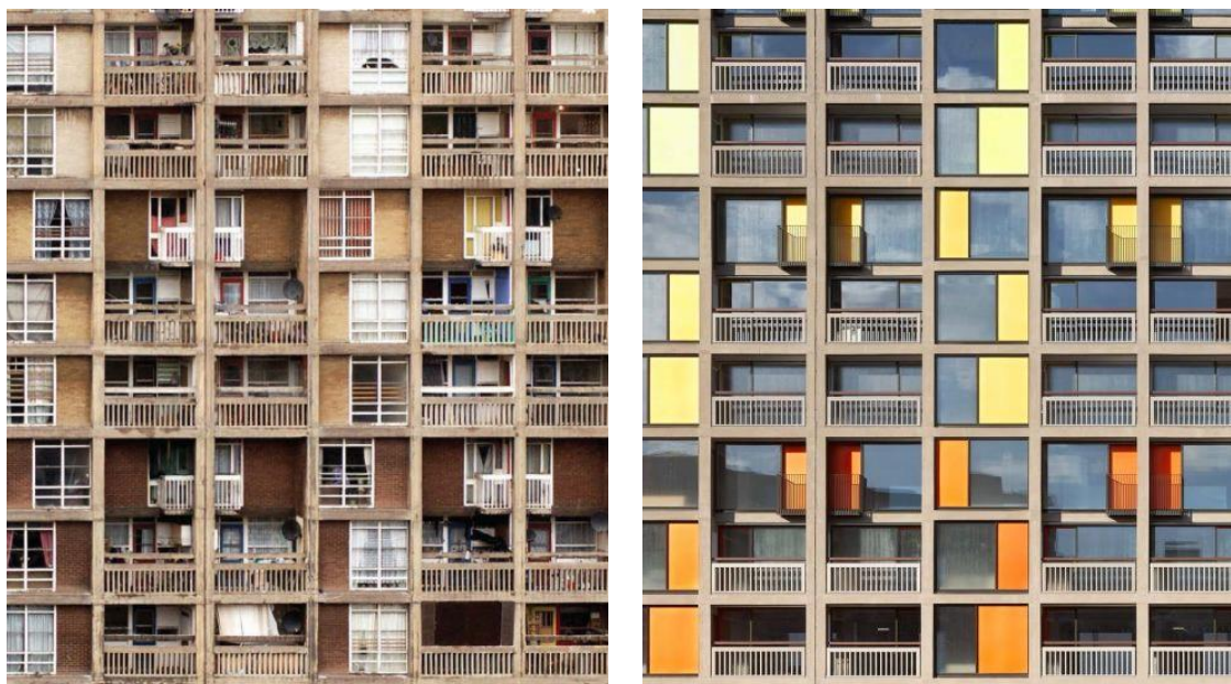
Figura 37 - Edificio residenziale a Sheffield, Inghilterra (www.hawkinsbrown.com)
