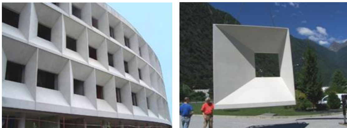
Figura 65 - Esempio di facciata in pannelli prefabbricati di GRC stampato dell'area Ex Bassetti di Vimercate (www.infobuild.it)
