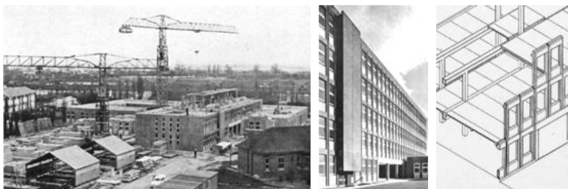
Figura 28 - Rush Green Hospital, Romford, UK, 1966-1968. Al fine di ridurre i tempi e la spesa per il trasporto degli elementi prefabbricati è stata impiantata sul lotto stesso dell'ospedale un'officina di prefabbricazione completa di impianto di stagionatura con una catena di produzione lunga 100 m
