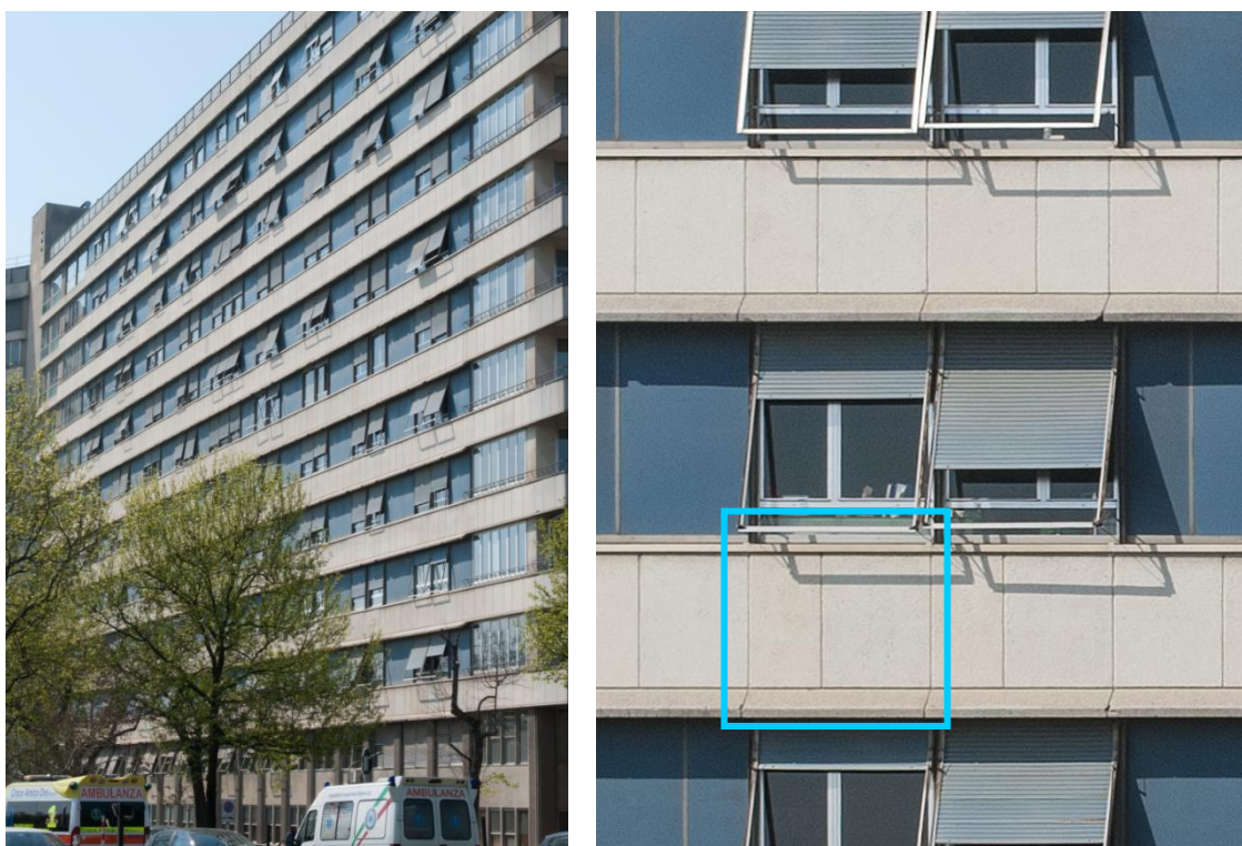
Figura 30 – Particolare dei pannelli prefabbricati della facciata degenze
