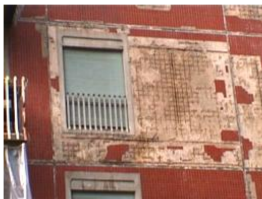
Figura 8 - Distacco delle tessere di rivestimento dei pannelli prefabbricati ( www.skyscrapercity.com )
