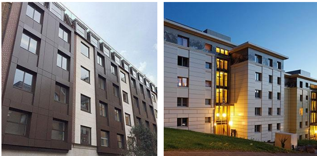
Figura 63 - Esempi di prospetti il cui motivo è determinato da arretramenti e avanzamenti della facciata (www.alucobond.com)
