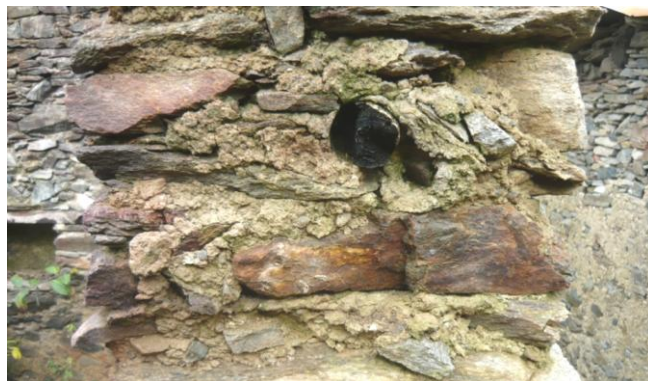
7.12_Sezione interna della muratura
