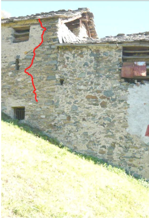
7.5_Lesioni per traslazione verticale di edifici contigui
