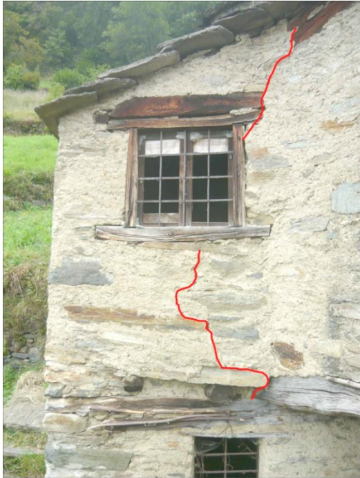
7.6_Lesioni per traslazione verticale di edifici contigui
