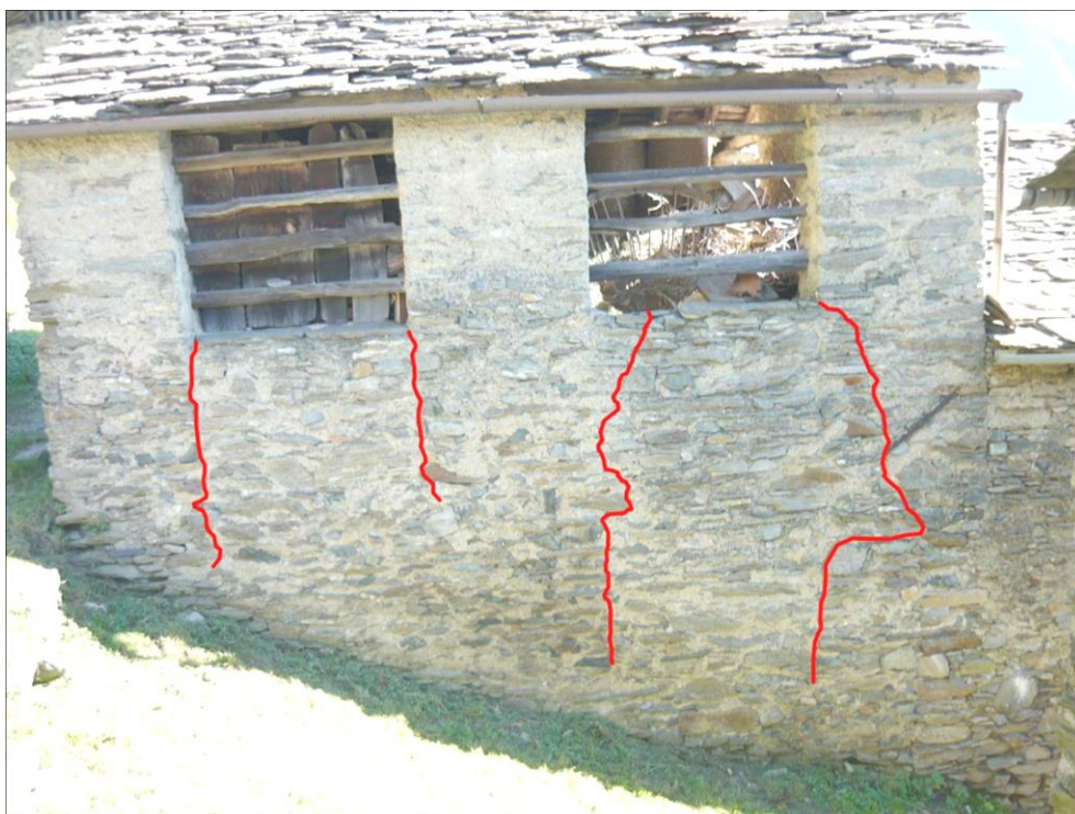
7.8_Lesioni per schiacciamento per peso proprio
