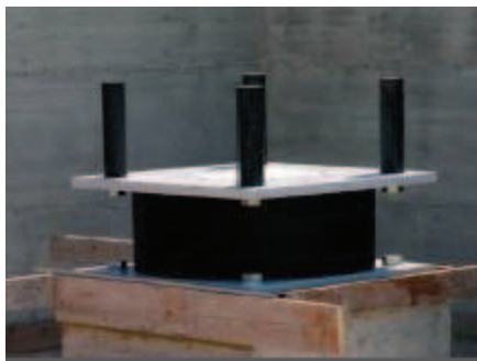
Figura 11.7.1 - Predisposizione della casseraatura per il getto di completamento
