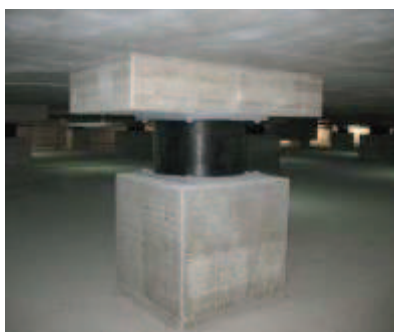
Figura 3.5.2 - Ispezione isolatori
