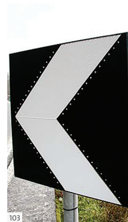
103. Esempio di segnale complementare utilizzato per segnalare curve pericolose e contemporaneamente segnale luminoso.
