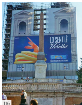
116. La facciata della Chiesa della Trinità dei Monti, in Piazza di Spagna a Roma, interessata da lavori di restauro è ricoperta da un telo con il disegno della facciata e una pubblicità di una nota marca di pasta italiana.
