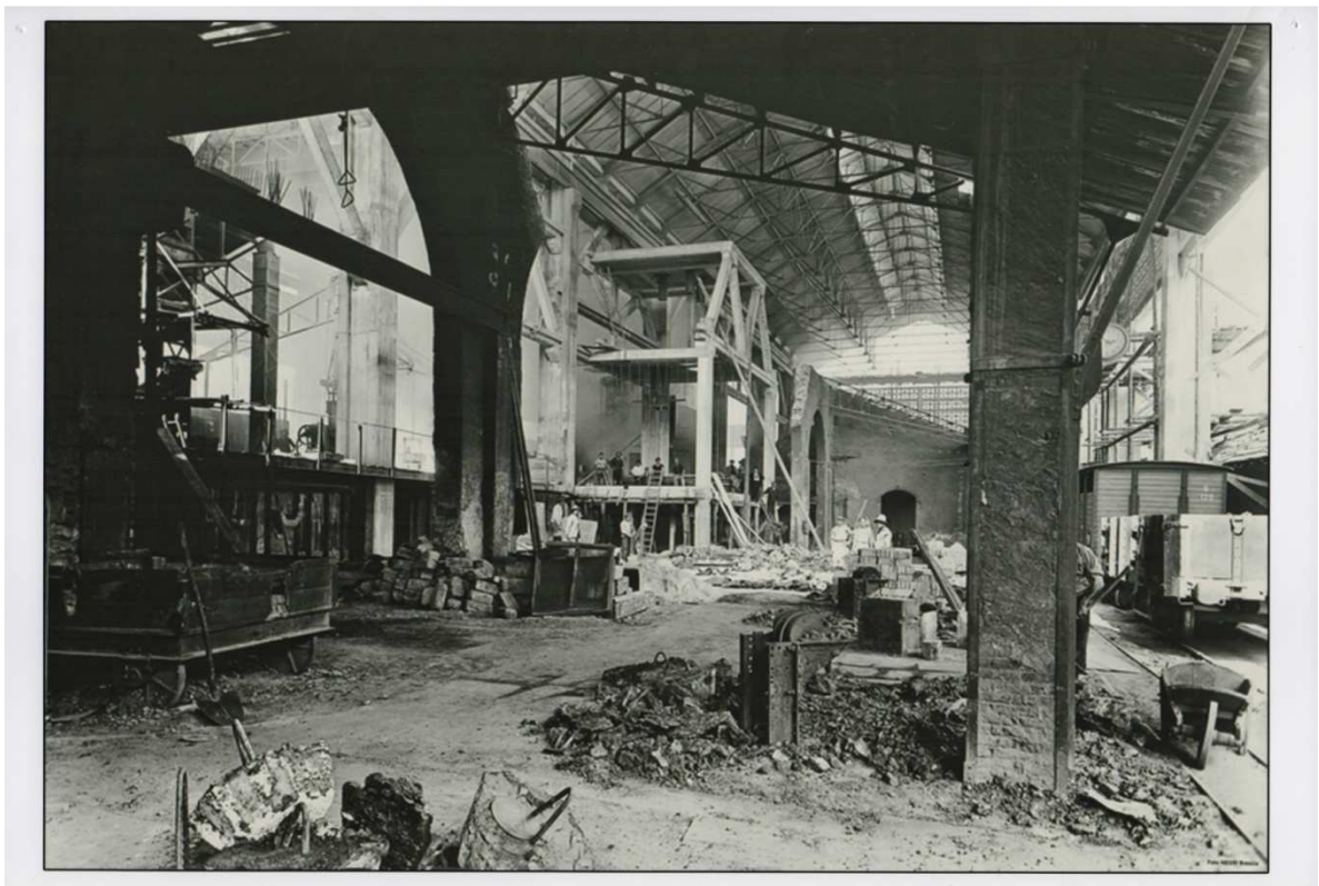
Figura. 29 - Fotografia interno impianto principale, lavori di realizzazione nuovi capannoni
