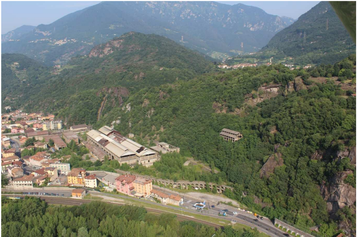
Figura. 36 - Fotografia aerea impianti nord 2015
