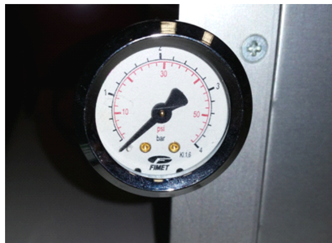
Figura 2.16: Manometro per pressione a monte EWG
