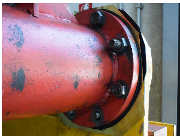
Figura 4.9: Imboccatura del lanciatore dopo il serraggio mediante lamine.
