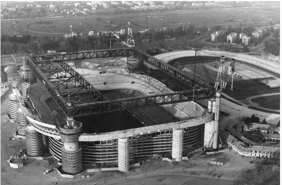
Giancarlo Ragazzi, Enrico Hoffer, Stadio San Siro, costruzione del terzo anello, Milano 1988
