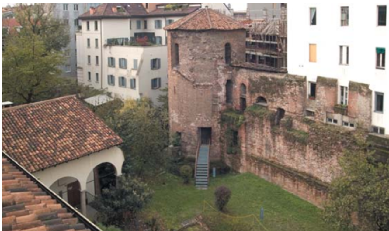
Veduta panoramica di un tratto della cinta muraria massimiana e dell'unica torre poligonale conservatasi, nel secondo chiostro del Museo Archeologico di Milano
