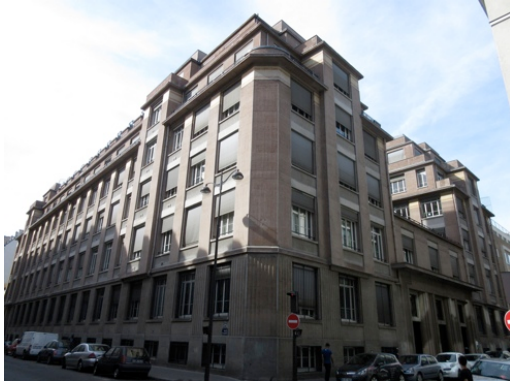
Entretien 67 : Gestionnaire d'infrastructure délégué SNCF, rue Traversière
