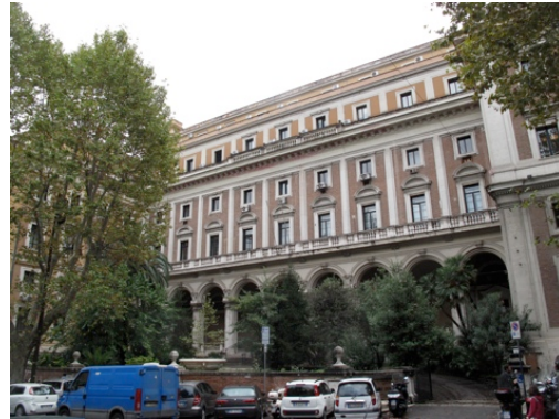
Entretien 93 : Ministero Infrastrutture e Trasporti, Via Nomentana, Rome
