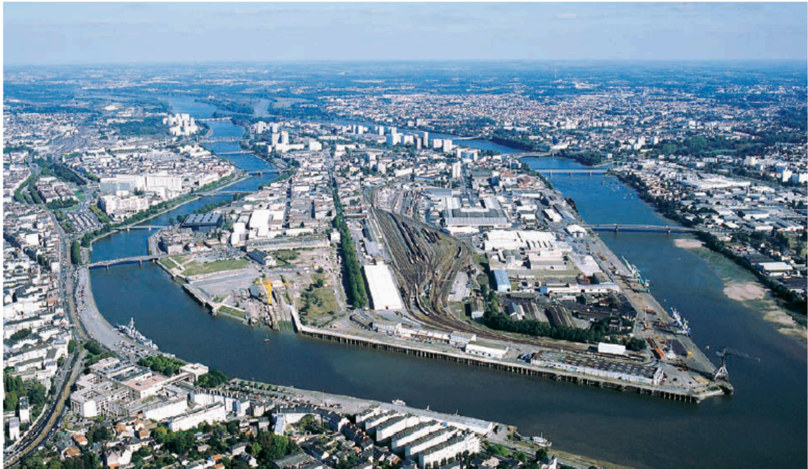
Figure 14 : Le périmètre inchangé du site de Nantes État au milieu des années 2000
