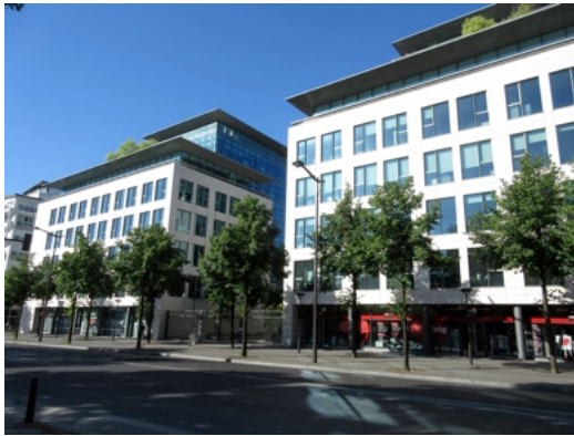
Entretien 57 et 58 : Direction régionale Ile-de-France, RFF, quai Panhard Levasseur
