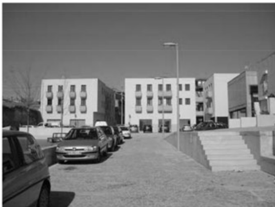
Figure 45, Habitação Económica nas Fontainhas, PER, 1996-2009, Helder Casal Ribeiro and Ana Sousa da Costa
