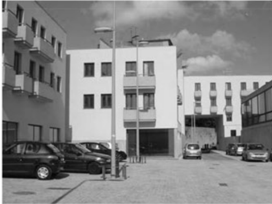
Figure 44, Habitação Económica nas Fontainhas, PER, 1996-2009, Helder Casal Ribeiro and Ana Sousa da Costa
