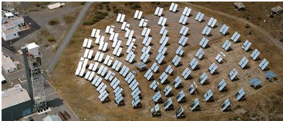
Fig. 1 Impianto CSP central tower di Almeria [7]
