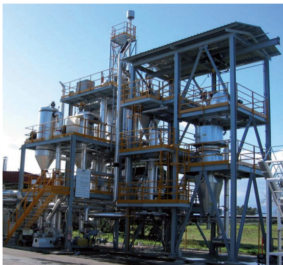
Figura 34. Impianto pilota di gassificazione delle biomasse a letto fluido ricircolante del centro ENEA della Trisaia (Rotondella, Matera).[5]
