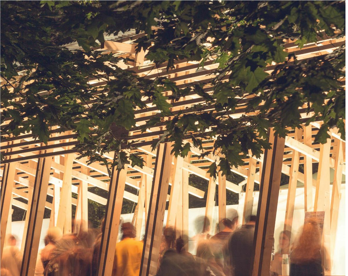
*Troppecolonne* è un bar, un'architettura temporanea realizzata per il festival Terraforma a Milano. L'elemento è costituito da una struttura modulare in legno; il legname utilizzato ha dimensione commerciale di 4 metri, non è stato quindi tagliato e ridotto per contenere la quantità di sprechi. La realizzazione è avvenuta in nove giorni di autocostruzione con l'aiuto di 15 studenti del Politecnico di Milano.
