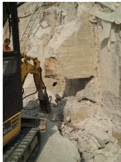
DEMOLIZIONE TROVANTI MURO LATO NORD
