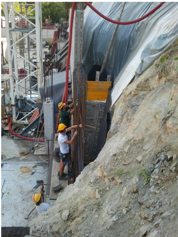
ESECUZIONE DI MURO CONTROTERRA A TAPPE LATO SUD
