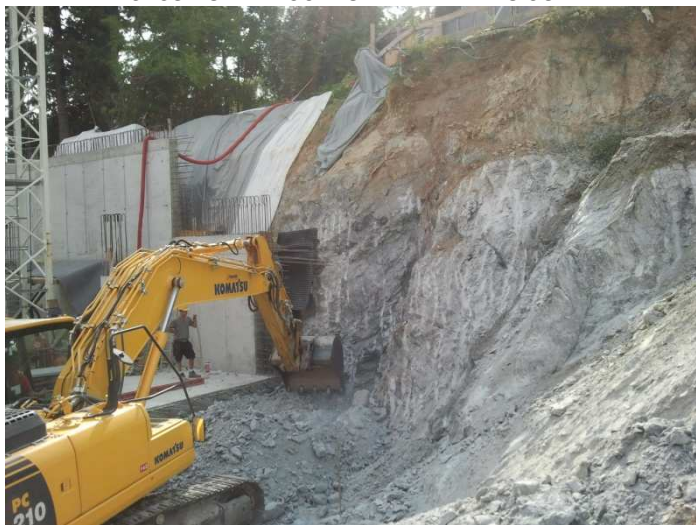
ESECUZIONE DI SCAVO A TAPPE LATO SUD
