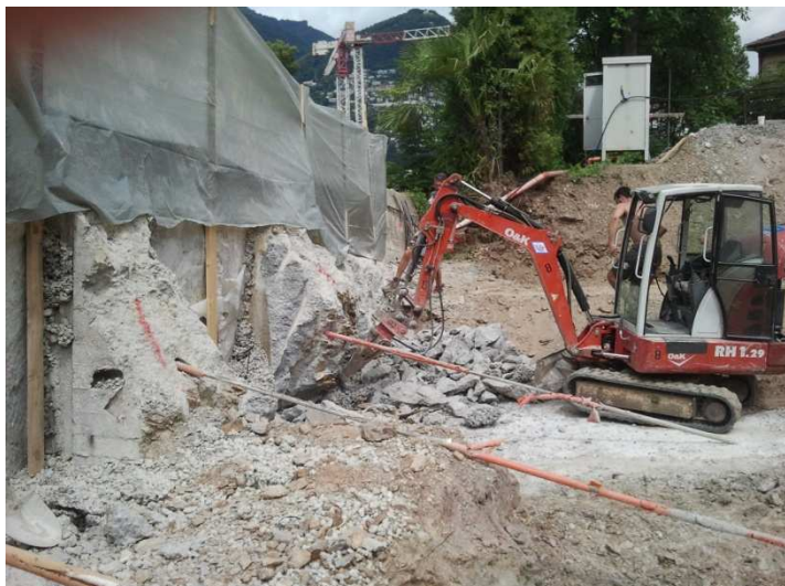
DEMOLIZIONE TROVANTI MURO LATO NORD
