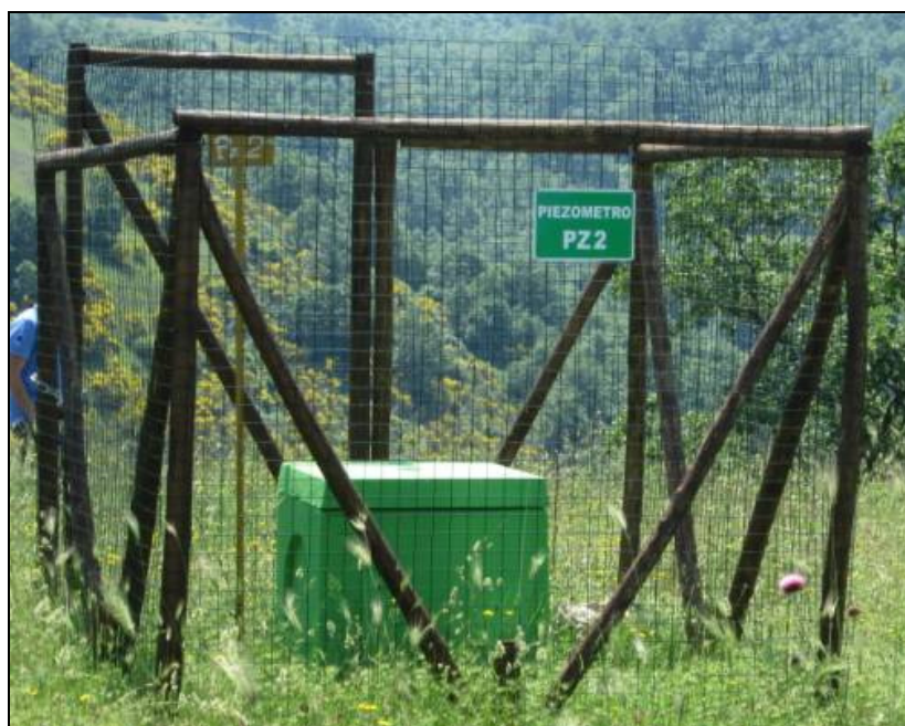
Figura 18 Piezometro per controllo acque sotterranee
