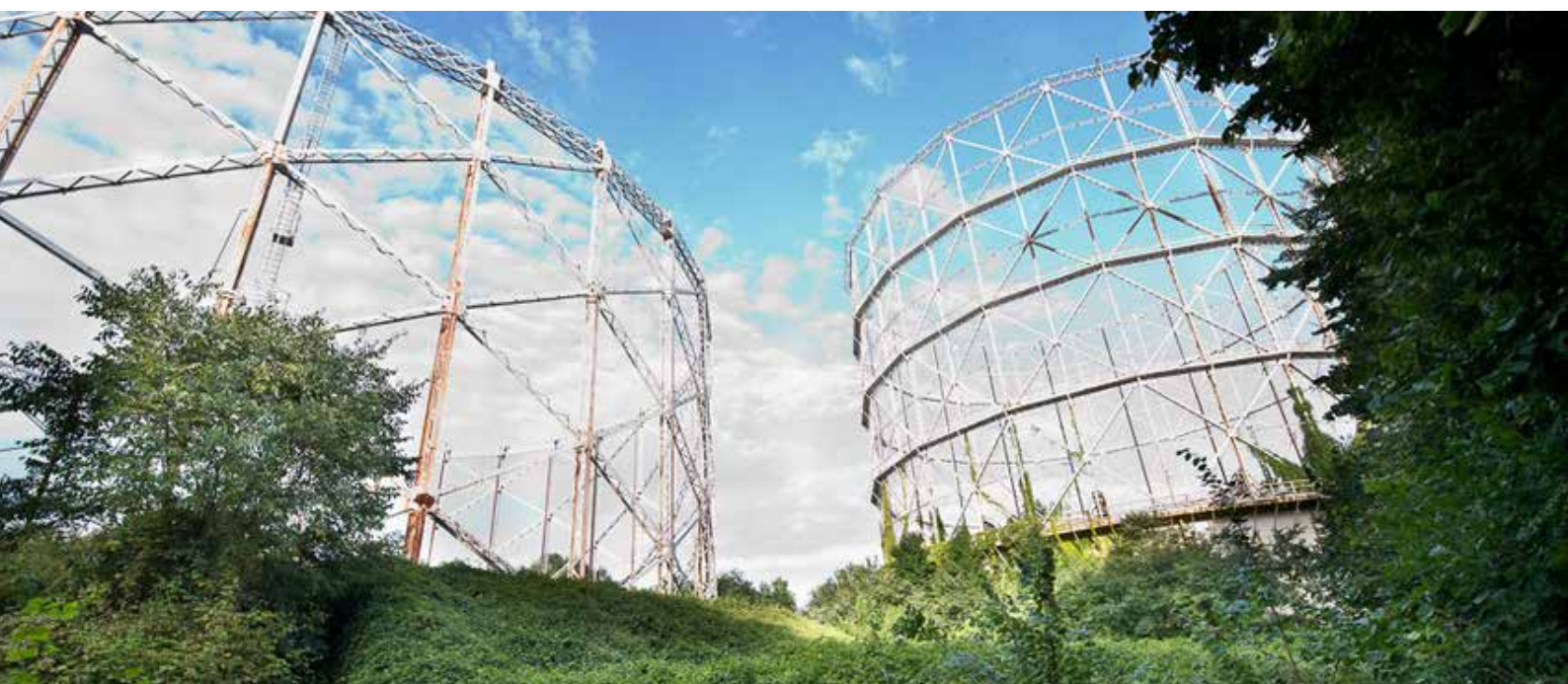
Immagine 102_La zona 9 ; I gasometri di Bovisa, strutture identificative del quartiere
