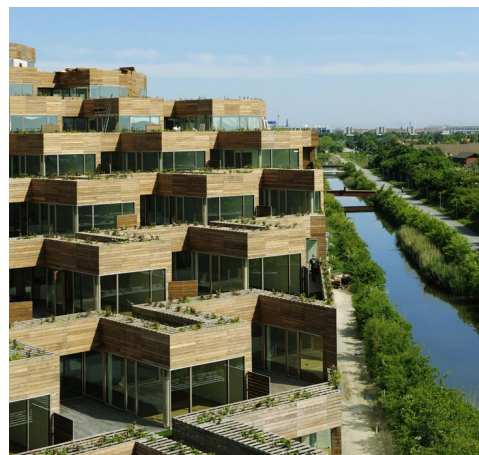
Fig.1.2. : BIG+JDS, Mountain Dwellings, 2008, Copenhagen, Danimarca. Vista dell'edificio di tipologia "a gradoni" con le coperture praticabili di pertinenza degli alloggi.
