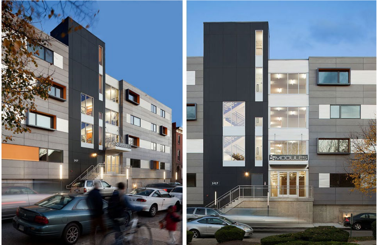
Fig.2.3.19: INTERFACE STUDIO Architects, Modular apartments, Philadelphia, 2010. Due vedute della facciata costruita con elementi di prefabbricazione.
