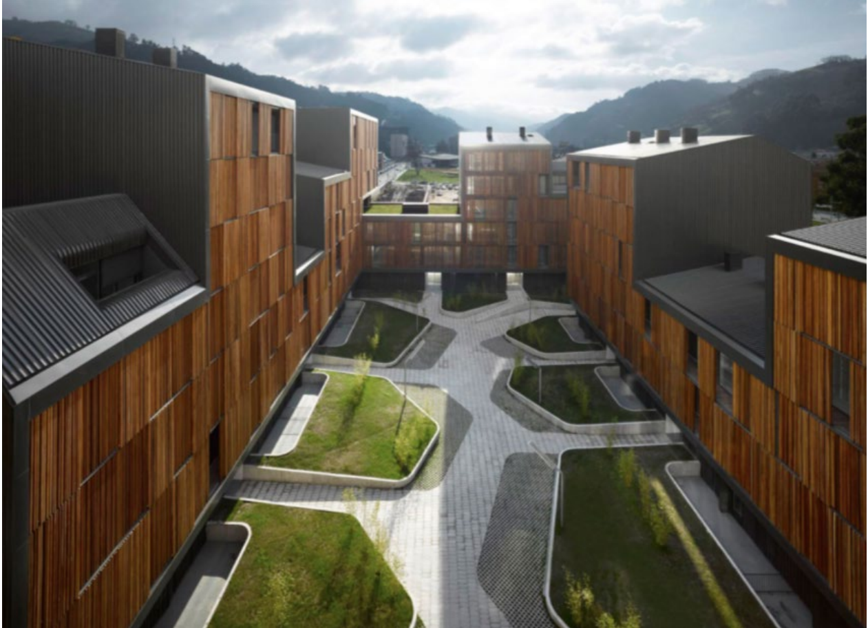
Fig.2.2.8. : ZigZag Architecture, Mieres Social Housing, 2010. Veduta nord-sud dell'intervento di residenziale sociale. (Foto Roland Halbe).
