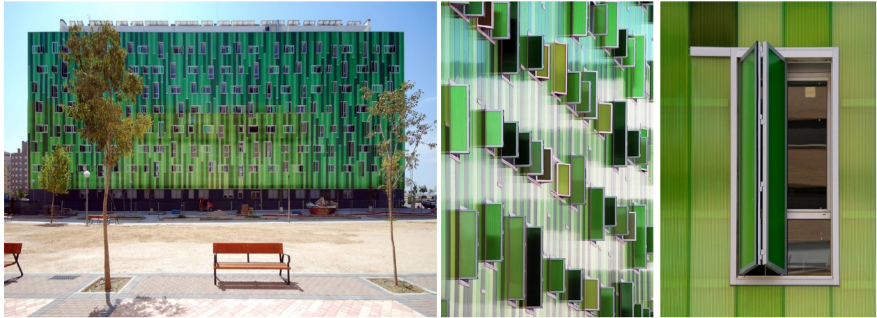
Fig.2.3.15: SOMOS Arquitectos, Social housing apartments, Madrid, 2009. Veduta esterna. Fig.2.3.16: SOMOS Arquitectos, Social housing apartments, Madrid, 2009. Dettagli dei pannelli di prefabbricazione utilizzati per la facciate e per le aperture verticali.
