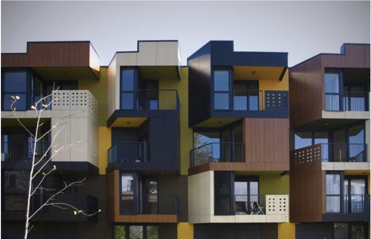
Fig.2.2.62: OFIS, TETRIS Apartments, Lubiana, 2007. Veduta della facciata e gli spazi aperti di pertinenza degli alloggi.
