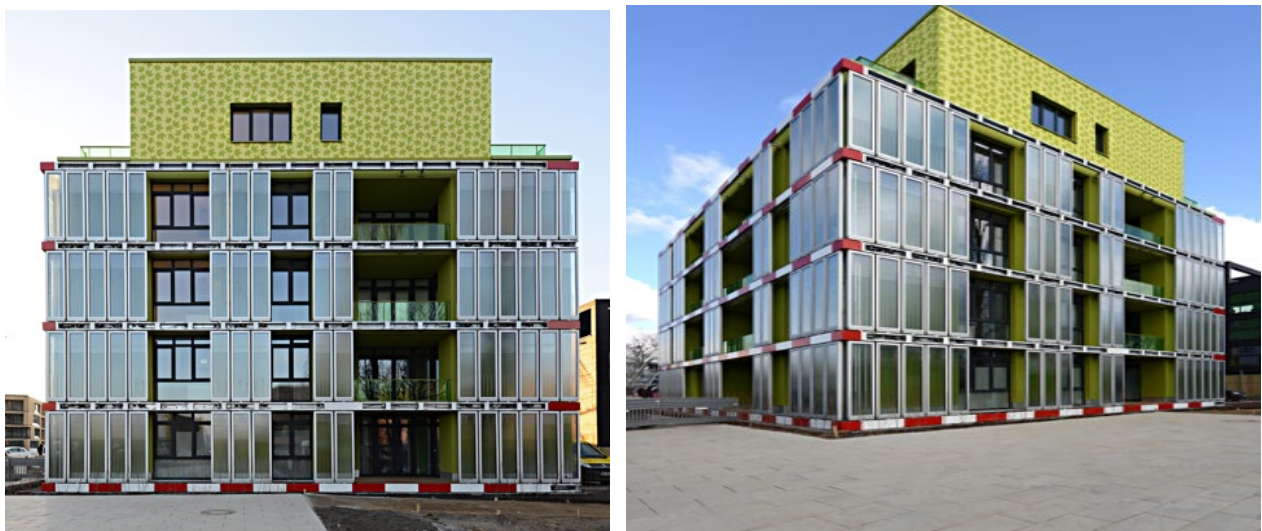
Fig.2.4.1: ARUP+SPLITTERWERK. BIQ HOUSE, IBA AMBURGO, 2013. Vedute esterne.
