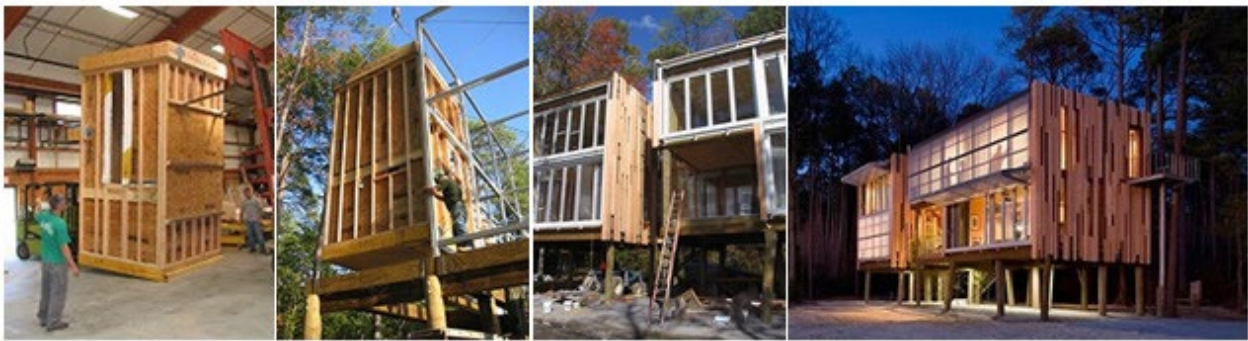
Fig.2.3.24: Kieran Timberlake, Loblolly House, Maryland, USA, 2006. Costruzione della struttura in stabilimento e montaggio in cantiere, sino al risultato finale.
