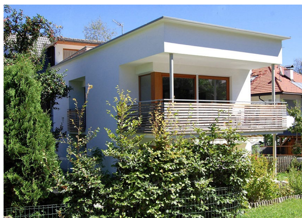
Fig.2.3.5: ALP HOUSE, Risanamento e ampliamento di casa residenziale, San Lorenzo, (Alto-Adige).
