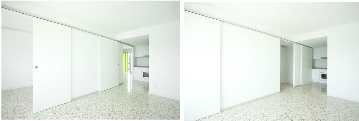
Fig.2.2.32 : Coll Lòpez & Leclerc, Social Housing, Lèrida, 2003. Vista interna degli alloggi con le pareti scorrevoli che determinano aggregabilità o scomposizione dello spazio abitabile.
