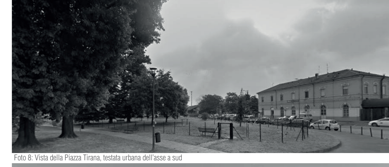
Foto 8: Vista della Piazza Tirana, testata urbana dell'asse a sud
