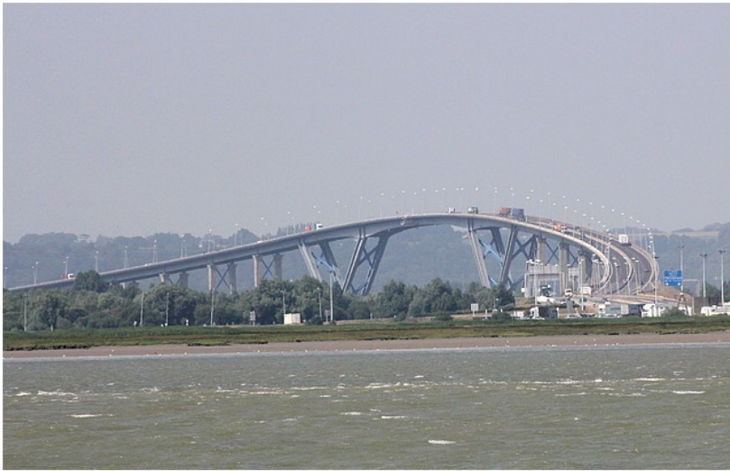
viadotto autostradale nel nord della Francia
