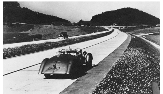
viste di due reichsautobahn, 1931 e 1937.
