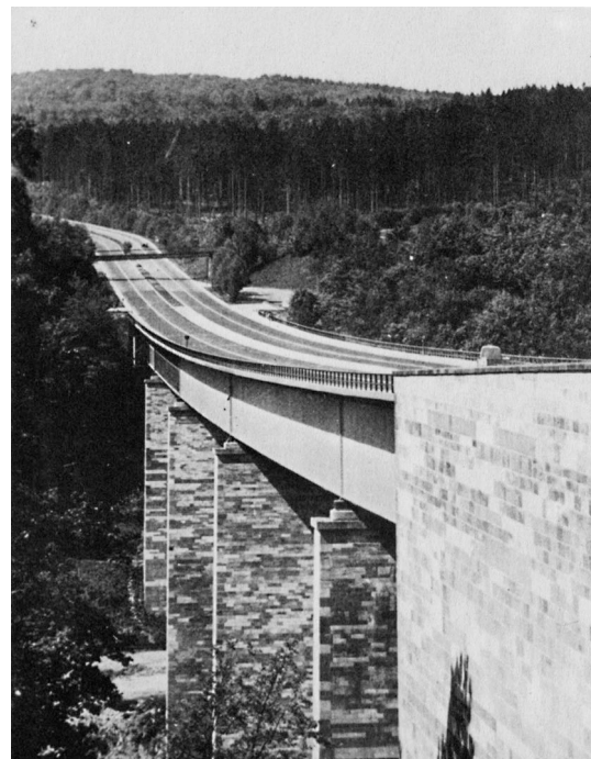
il ponte autostradale presso Hedemünden, costruito nel 1937, si presentava come un piano orizzontale rigido al di sopra della valle della Werra. Nella ricostruzione la sovrastruttura fu adattata all'andamento del percorso (MULLER, 1981)
