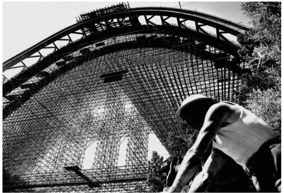
Zona di Pian del Voglio, nel tratto Bologna-Firenze: le centine del viadott Biscione (AUTOSTRADE PER L'ITALIA S.P.A., 2006)
