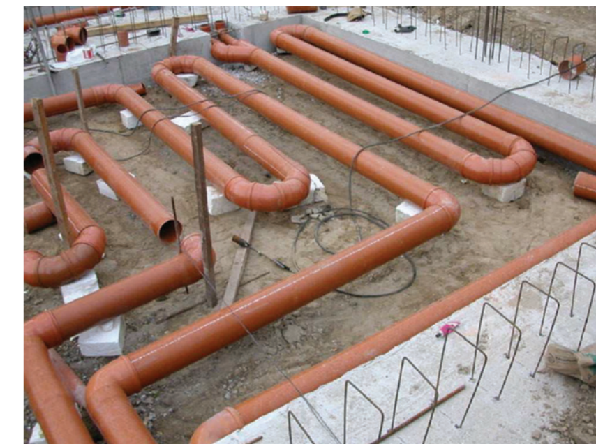
Figura 7.45 Posizionamento delle tubazioni dello scambiatore di calore
