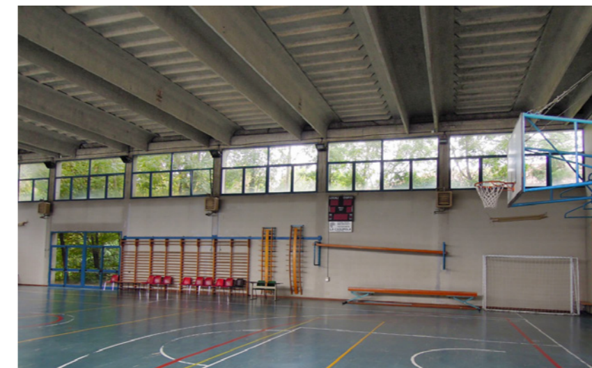
Figura 9.5 Vista d'insieme del sistema di copertura
