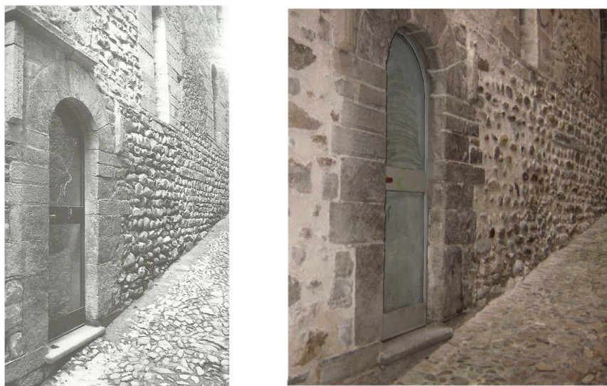
Figura 16. Confronto dello stato di conservazione degli elementi della parete meridionale: a sx, foto da O. ZASTROW, op. cit. , p. 83; a dx, foto dell'Autore.
