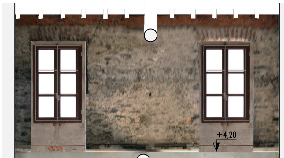
Figura 21. Muratura perimetrale sud — dettaglio della superficie interna (foto dell'Autore).
