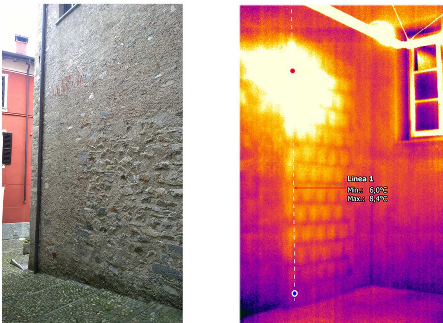
Figura 20. Muratura perimetrale sud — dettaglio 3 (confronto fra fotogramma esterno e termogramma interno, foto dell'Autore).
