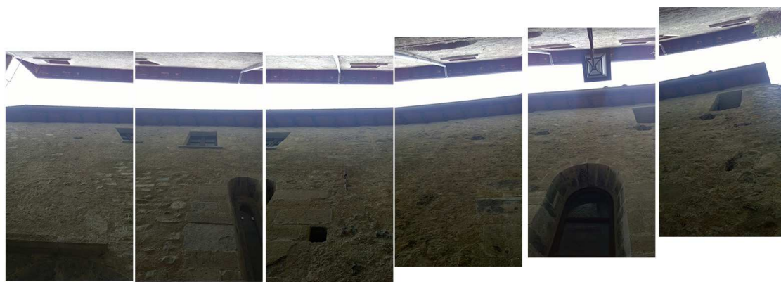
Figura 18. Muratura perimetrale sud — dettaglio 2 (foto dell'Autore).
