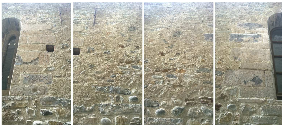
Figura 17. Muratura perimetrale sud — dettaglio 1 (foto dell'Autore).
