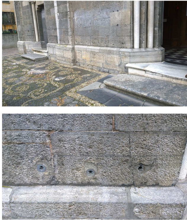
Figura 40. Chiesa dei SS. Giorgio, Nazaro e Celso, Bellano. Particolare del sistema di “taglio chimico” (foto dell’Autore).
