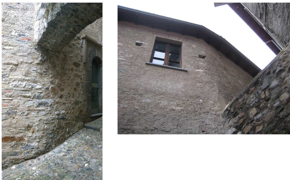
Figura 22. Muratura perimetrale sud — dettaglio 4 (foto dell'Autore).
