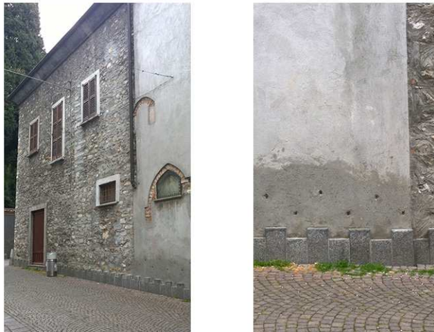
Figura 41. Chiesa di Santa Marta, Bellano. Particolare del sistema di “taglio chimico” (foto dell’Autore).
