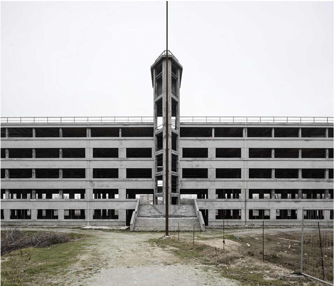
Figura NN. la torre monumentale
