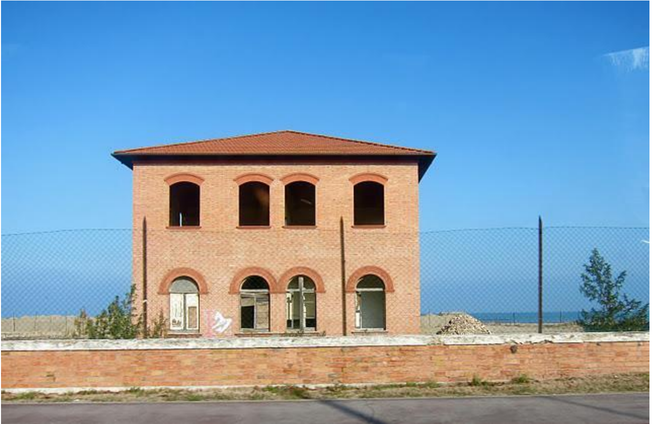
Figura NN. sopralzo dell'ex lavanderia
