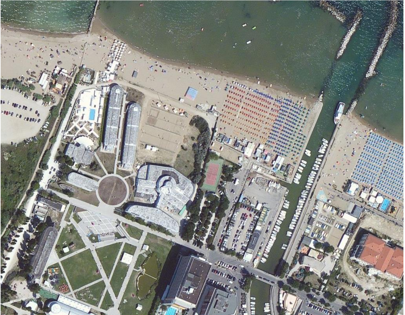
Figura NN. colonia Le Navi dopo le demolizioni, www.bing.com
