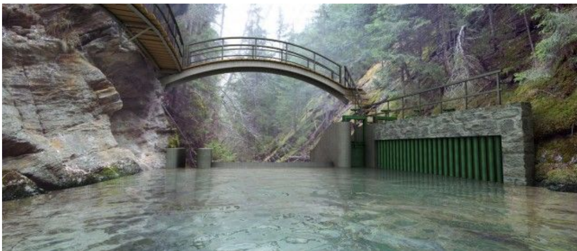
Figura 2.3 Esempio di opera di presa laterale
