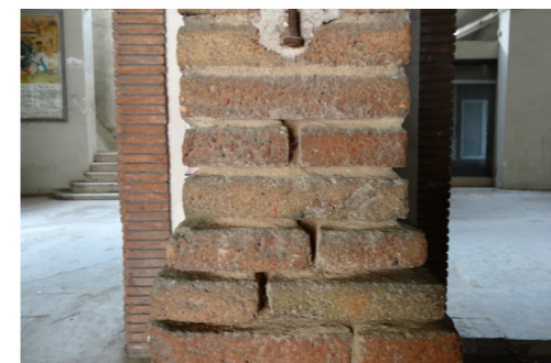
Confronto tra i due tipi di mattoni usati in alto un dettaglio dell'edificio originale e in basso uno seguente al suo ampliamento
