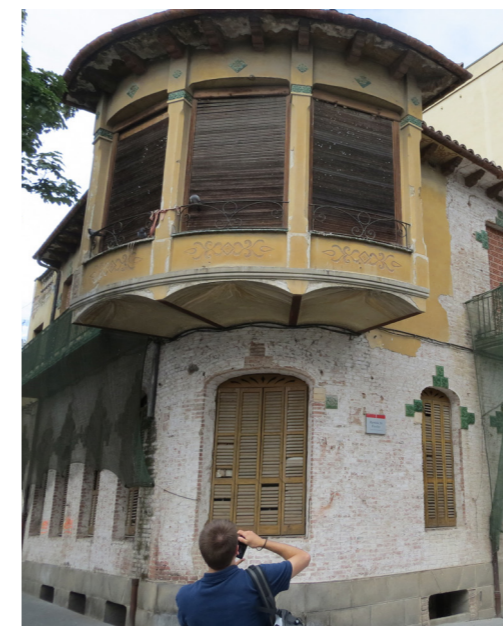
Aubin davanti all'edificio dell' "Antiga acadèmia di Mollet", opera di Domenech Sugañes i Gras oggi in fase di restauro
