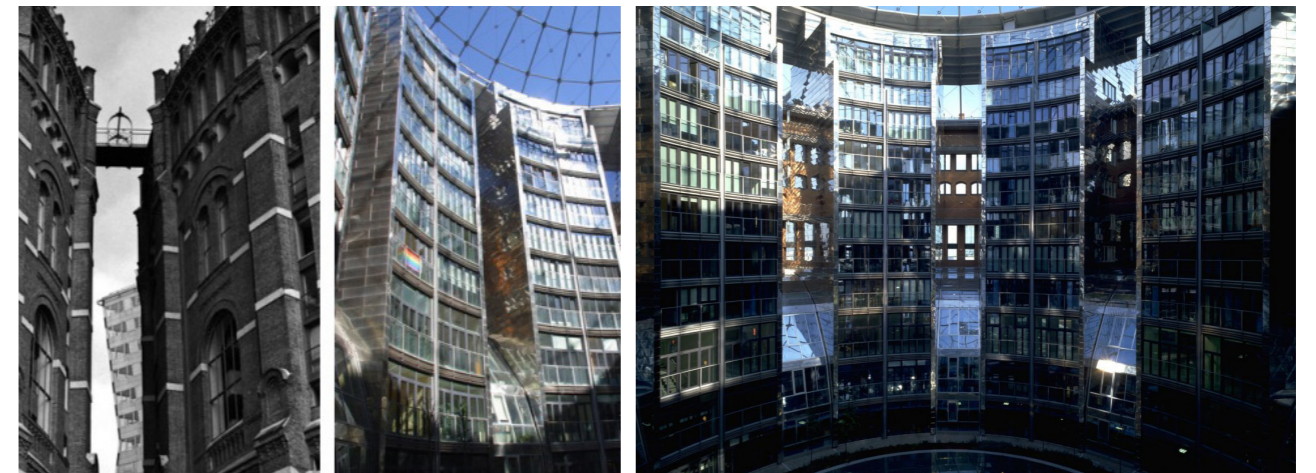
Sotto alcuni particolari dell'intervento architettonico di Jean Nouvel
