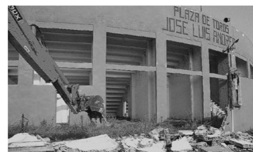
Arene demolite: - Arena di Girona, prima della sua demolizione - Arena di Girona, dopo la sua demolizione - Demolizione dell'arena di Lloret del Mar
