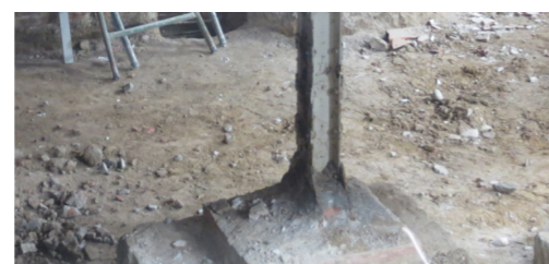
Dettaglio preso nell'"Antiga academià di Mollet del Valles", arch. Domenech Sugrañes i Gras
