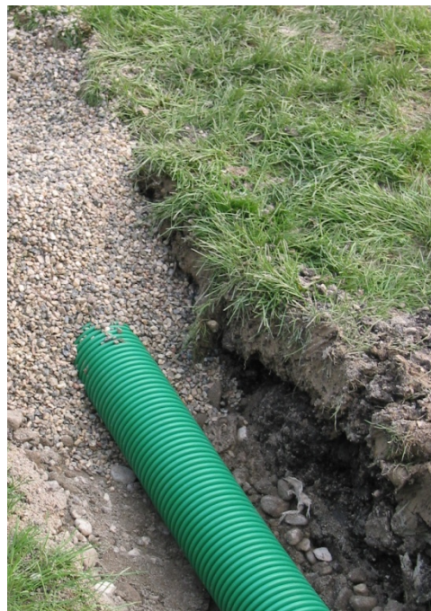
Figura 158: particolare del posizionamento del tubo di drenaggio
