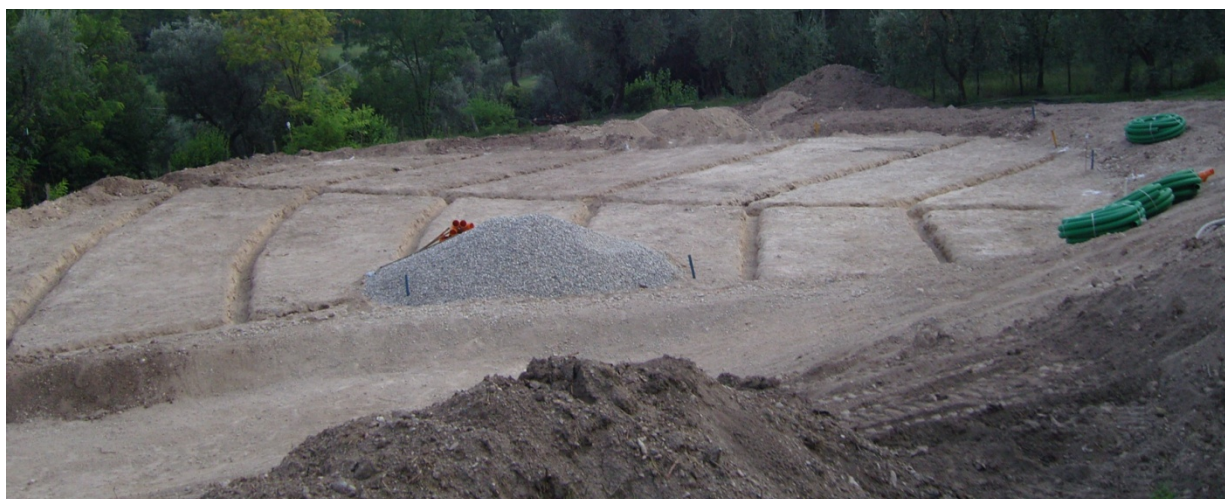
Figura 152: realizzazione drenaggi sul green della nuova buca 3
