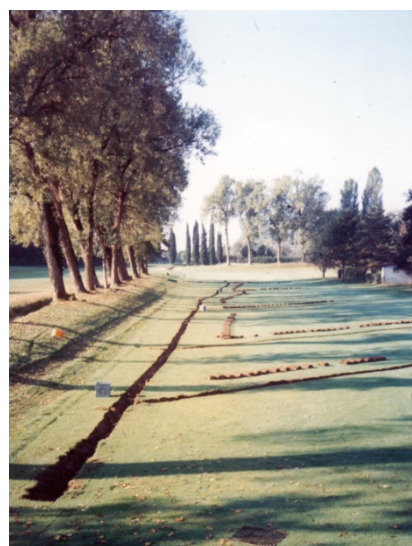
Figura 159: 1988 realizzazione scavi drenaggi buca 1
