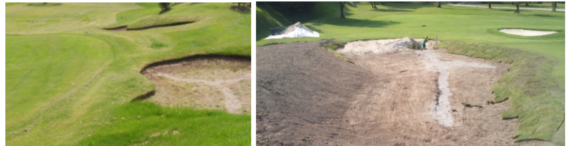
Figura 162 : 2008 buca 4 i nuovi bunkers con i drenaggi
