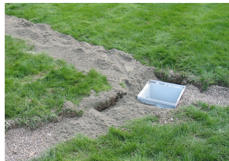
Figura 161: particolare del drenaggio e del pozzetto
