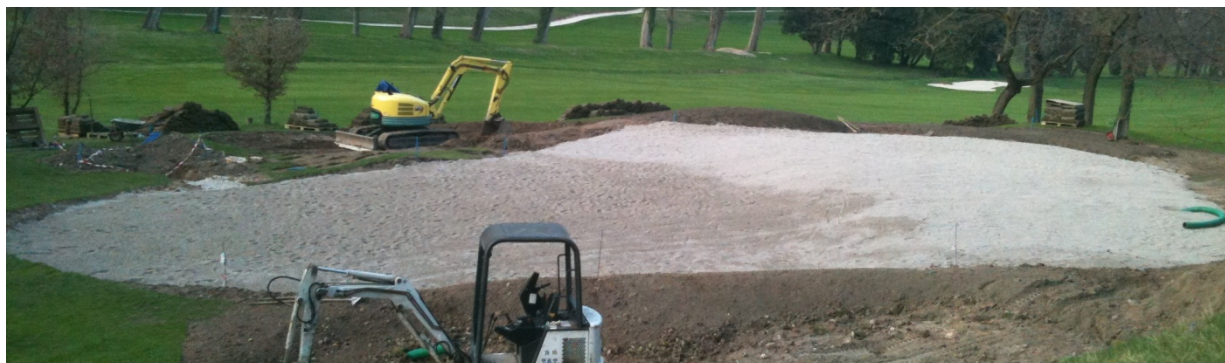
Figura 149: 2010 fasi della costruzione green buca 7 stesura terriccio
