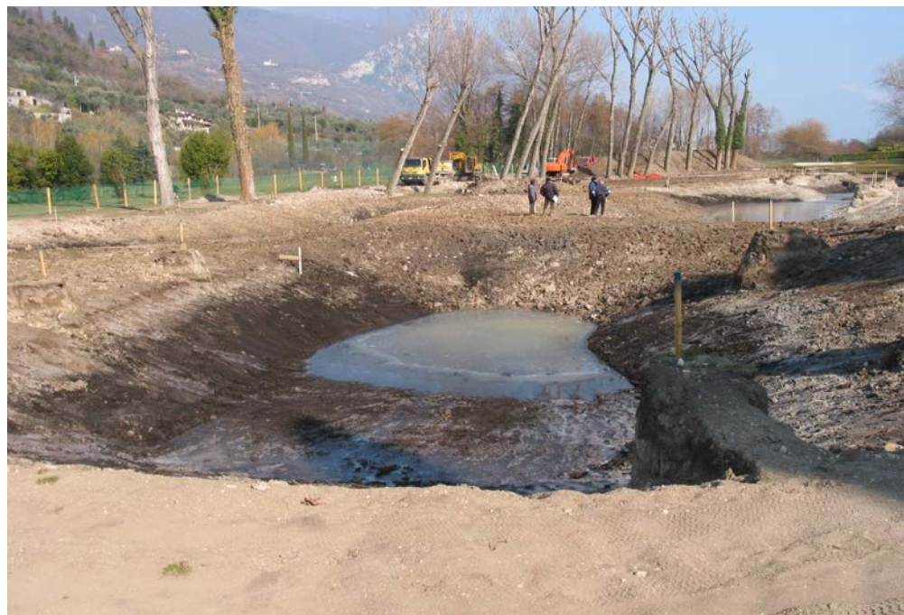
Figura 166: 2005 fasi di scavo del nuovo lago della buca 11
