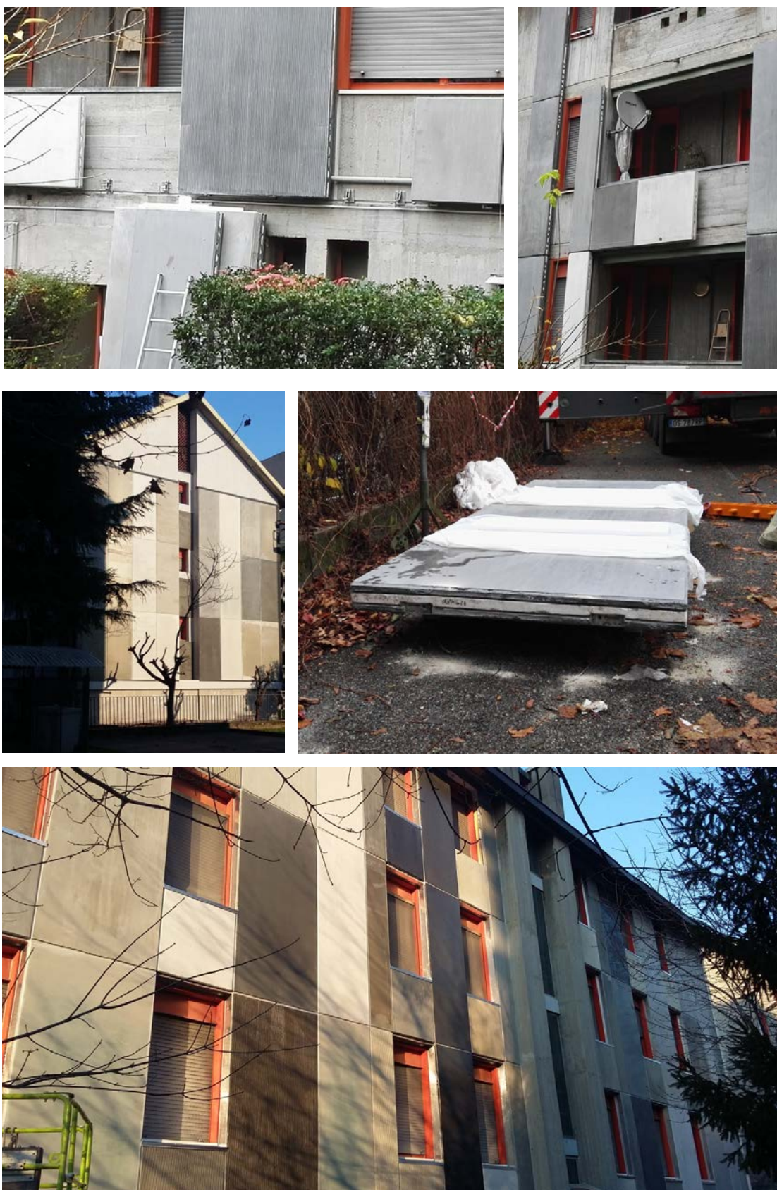
Figura 5. Collage di foto : Fasi realizzative dell'intervento a Cinisello Balsamo.
