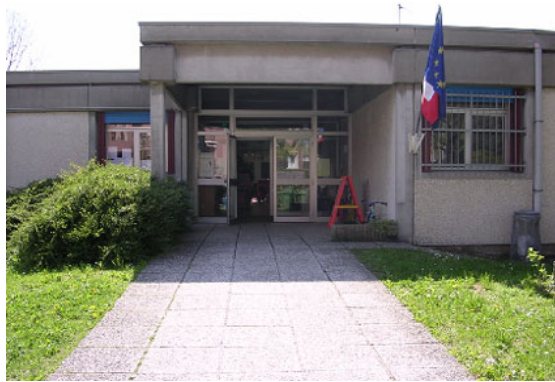
Figura 20. Istituto Comprensivo di Calolziocorte
