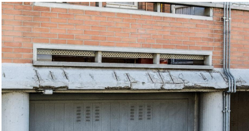
Figura 10. Dettaglio armatura trave
