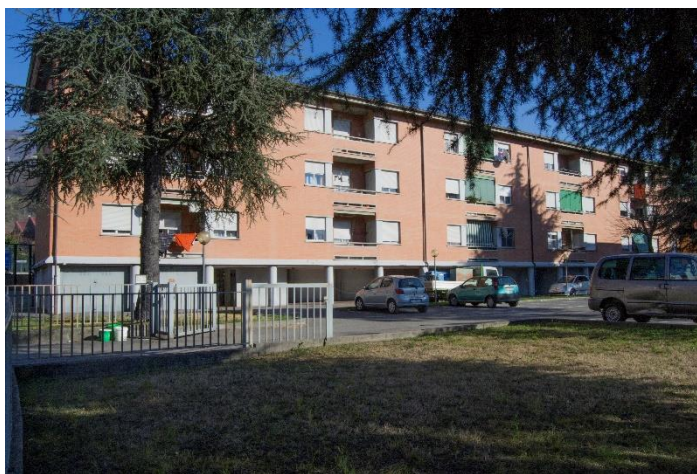
Figura 3. L' entrata al lotto di progetto, fronte Sud
