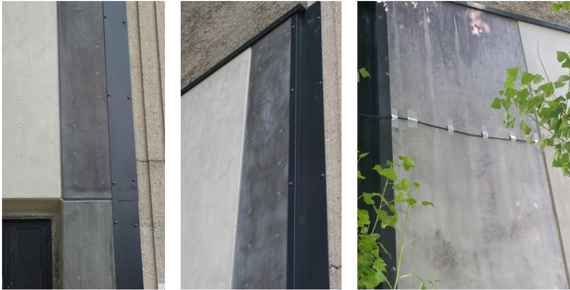
Figura 3. Dettagli dei Pannelli EASEE nella Test Facades a Milano.
