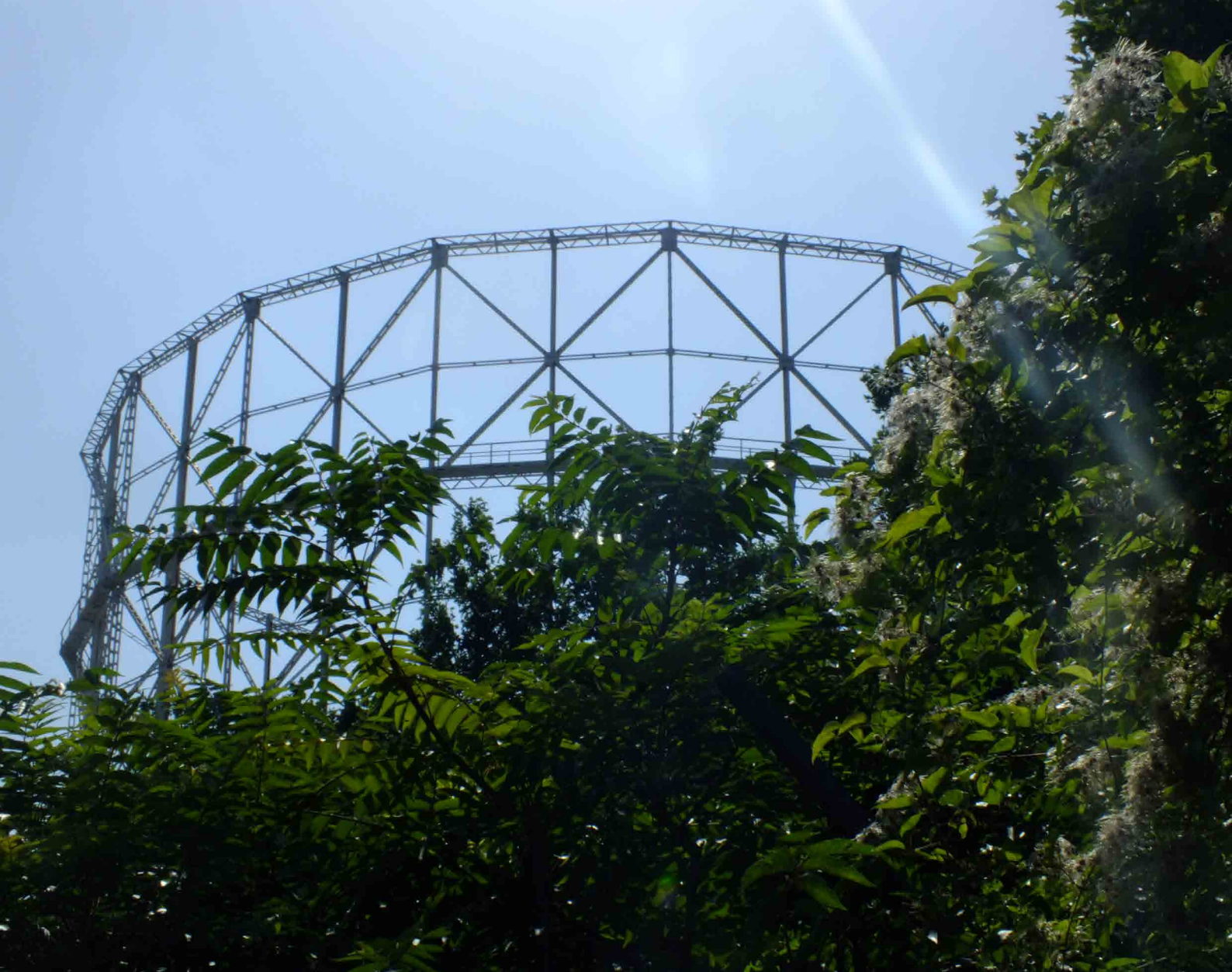
Le strutture dei gasometri sbucano dal bosco spontaneo della goccia, a Bovisa
