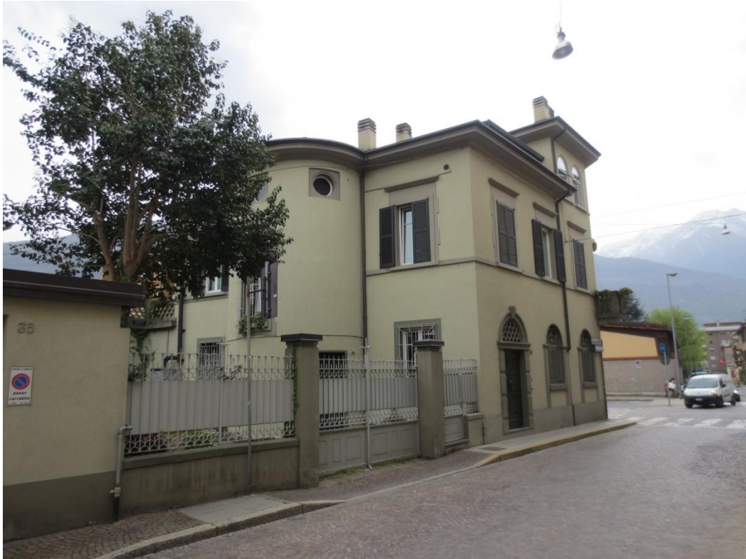
Fig. 5.3.14 Edificio 17, Via Alessi 39, Sondrio.
