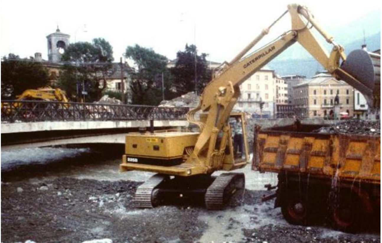
Fig. 2.1.3 Alluvione del 1987, Sondrio. Lavori di rimozione sedimenti dal letto del torrente.
