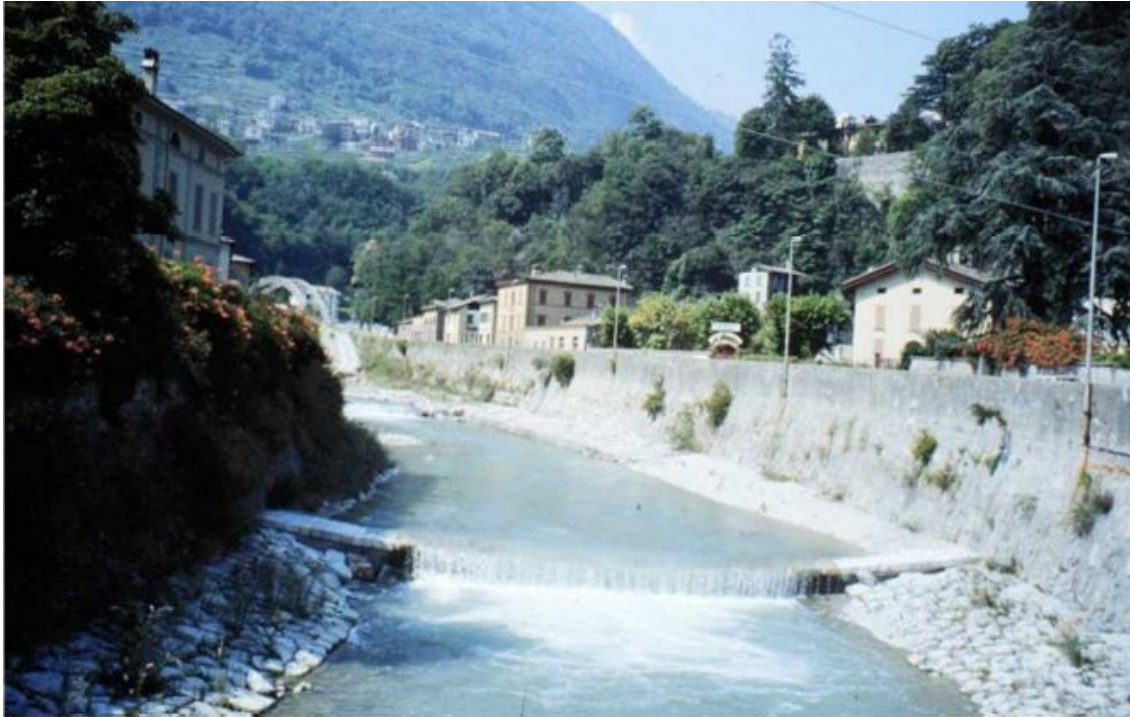
Fig. 2.3.4 Esempio di sezione di valle (nei pressi di sezione 69, Sondrio). Si nota un alveo artificiale, ampio e poco pendente.
