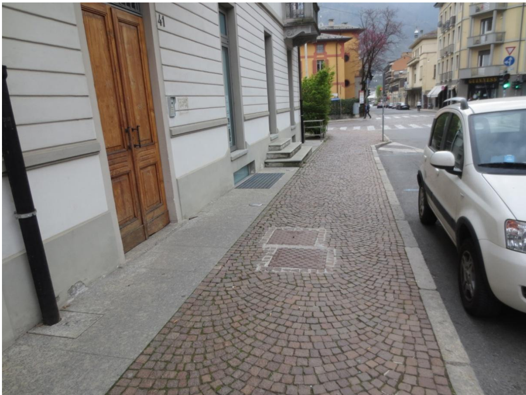
Fig. 5.3.13 Edificio 4, Via Caimi 41, Sondrio. Altezza del piano terra a filo del marciapiede, solo 10 cm al di sopra del piano stradale.
