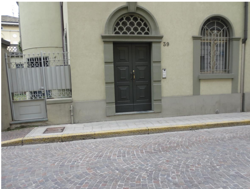
Fig. 5.3.15 Edificio 17, Via Alessi 39, Sondrio. Altezza del piano terra a circa 30 cm dal piano stradale.
