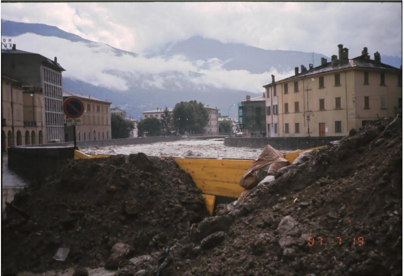
Fig. 2.1.2 Alluvione del 1987, Sondrio. Argine di contenimento provvisorio dopo straripamento.
