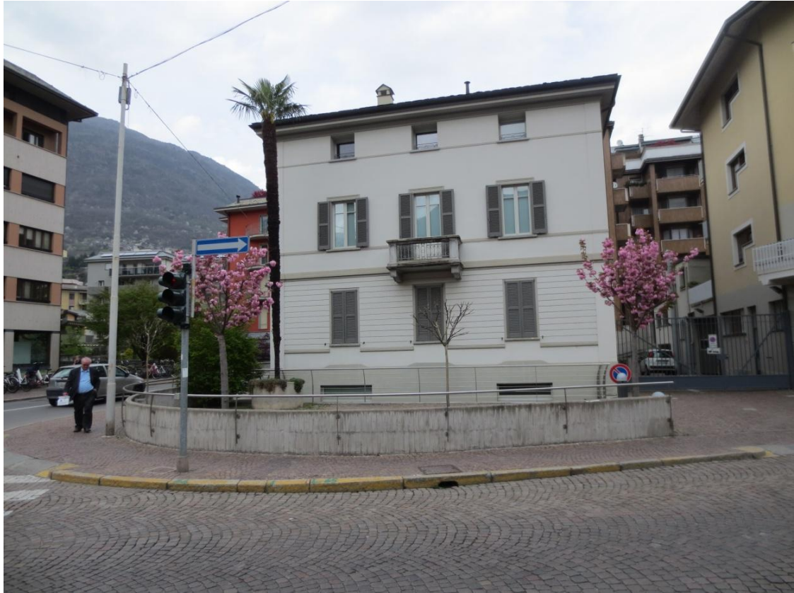
Fig. 5.3.12 Edificio 4, Via Caimi 41, Sondrio. Vista frontale.
