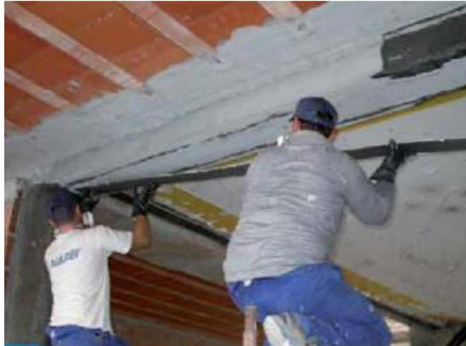
Fig. 147 - posizionamento di lamina in FRP – estratta dal “Manuale del rinforzo strutturale” edito da Mapei
