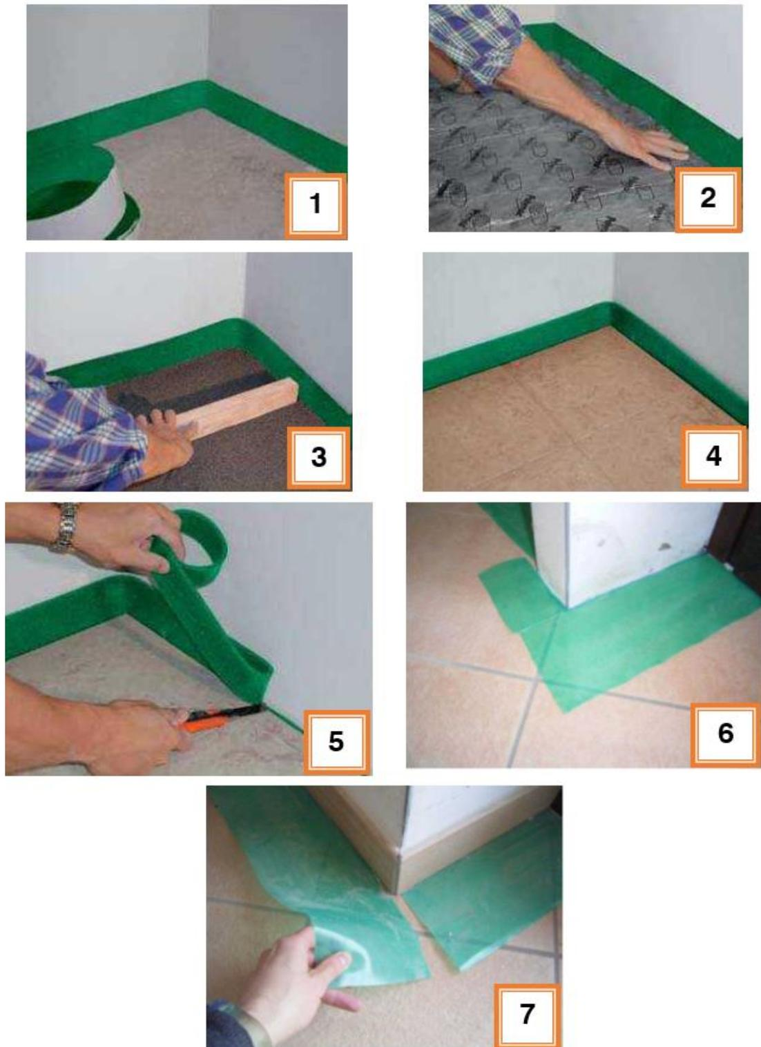
Fig. 85 - Modalità di corretta posa di tappetino isolante
