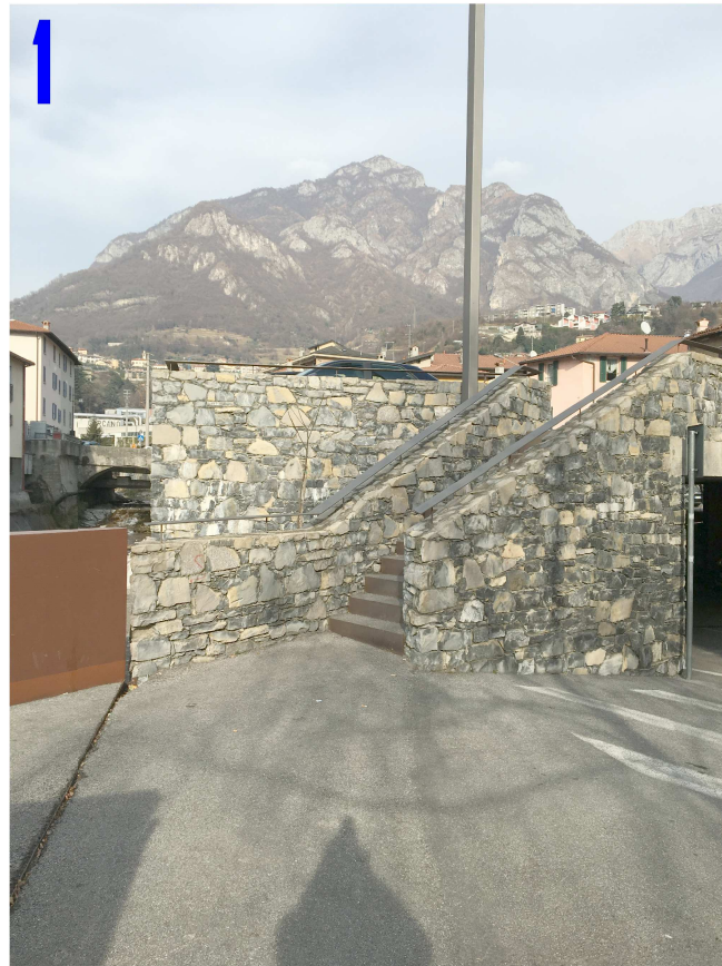
VISTA NORD-OVEST - PARCHEGGIO
