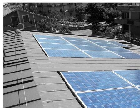
PANNELLI FOTOVOLTAICI INTEGRATI
