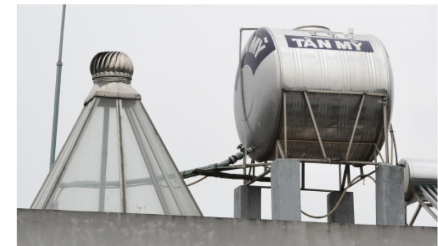
Figura 2.12 Vista su tetti di Hanoi e dettaglio delle piramidi di ventilazione
