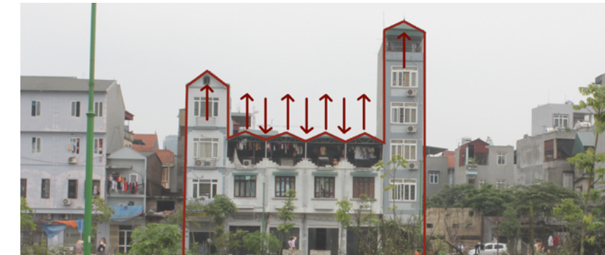
Figura 2.11 Tipico "up&down" delle tube houses, qui a Phu Do, sul sito di progetto
