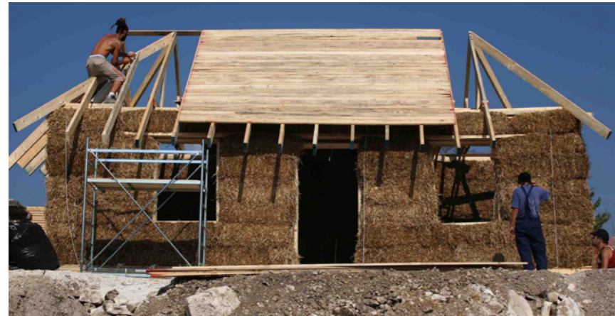
Figura 3.15 Esempio di costruzione in paglia
