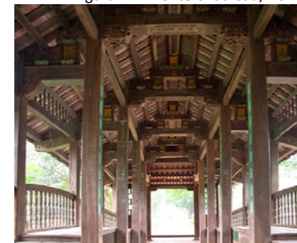
Figura 4.19 Pnd Bridge, dettagli interni
