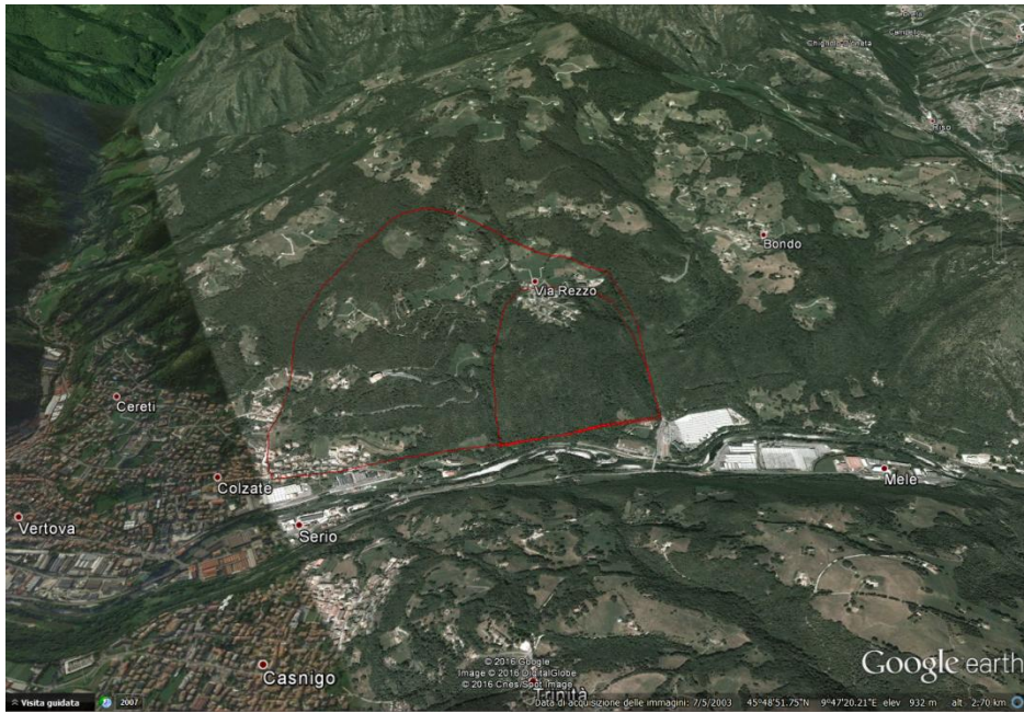
Figura 21: foto aerea del versante del Monte Cavlera che si affaccia sulla Val Seriana; i segni rossi delimitano i fenomeni gravitativi (fonte: Google Earth)
