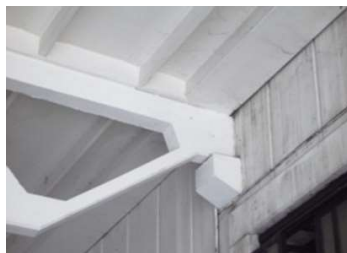
Figura 2.1 Esempio di appoggio attritivo pilastro-trave
