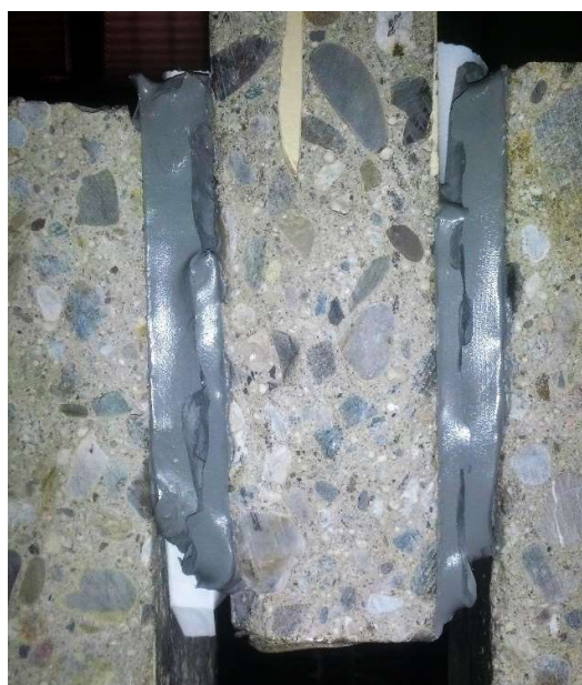
Figura 4.32 Esempio della rottura interna del giunto di silicone
