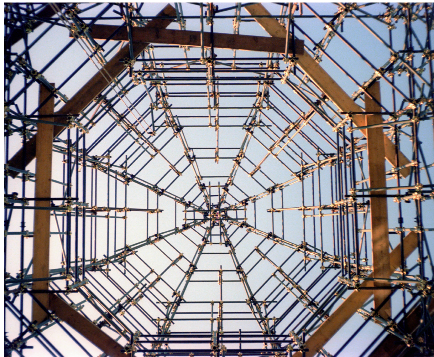
Copertura in tubolari d'acciaio del Teatro del Mondo, 1979. Archivio personale di Paolo Portoghesi.
