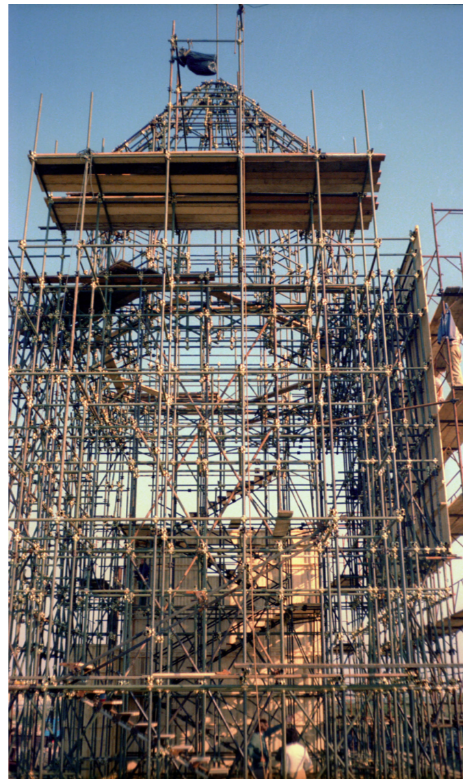
Ossatura in tubolari d'acciaio del Teatro del Mondo, 1979. Archivio personale di Paolo Portoghesi.
