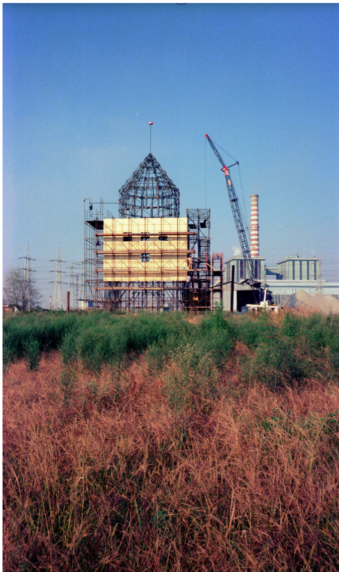
Teatro del Mondo in costruzione, 1979. Archivio personale di Paolo Portoghesi.
