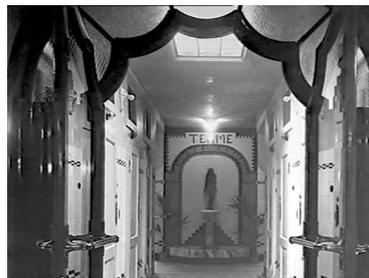
to con griglie di ripresa incorporate. Le cabine sono quasi tutte ancora corredate dell'impianto di riscaldamento con strutture angolari rivestite di piastrelle di opalite colorata e dotate di bocchette in alluminio per il passaggio dell'aria calda.
