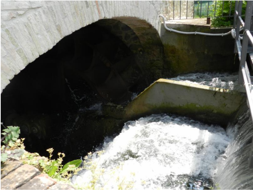
Figura 21: in evidenza la turbolenza del fluido a monte della ruota
