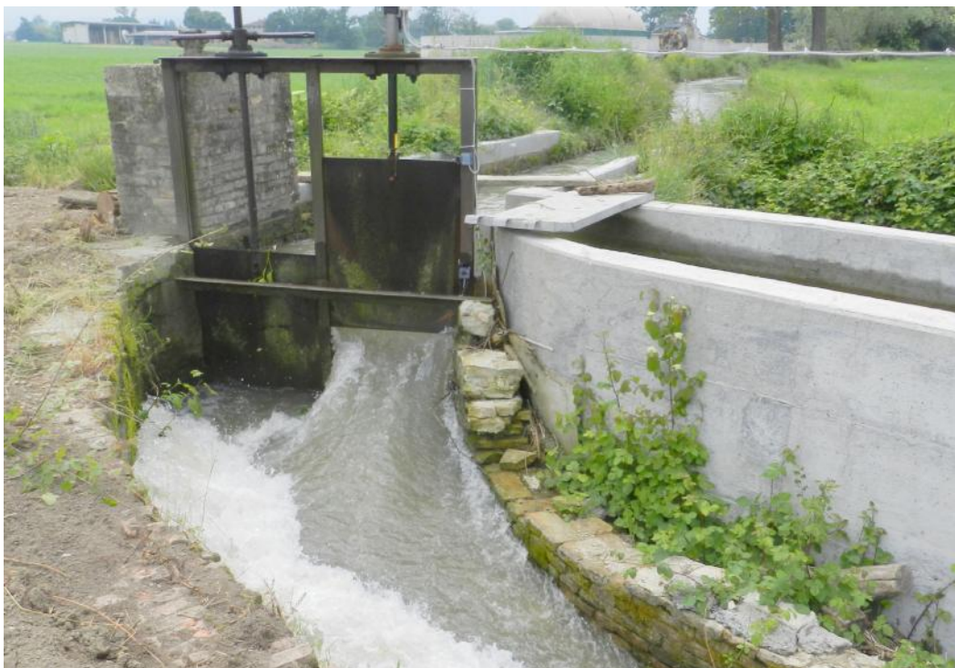
Figura 10: paratie della ruota Sforza viste da due differenti angolazioni
