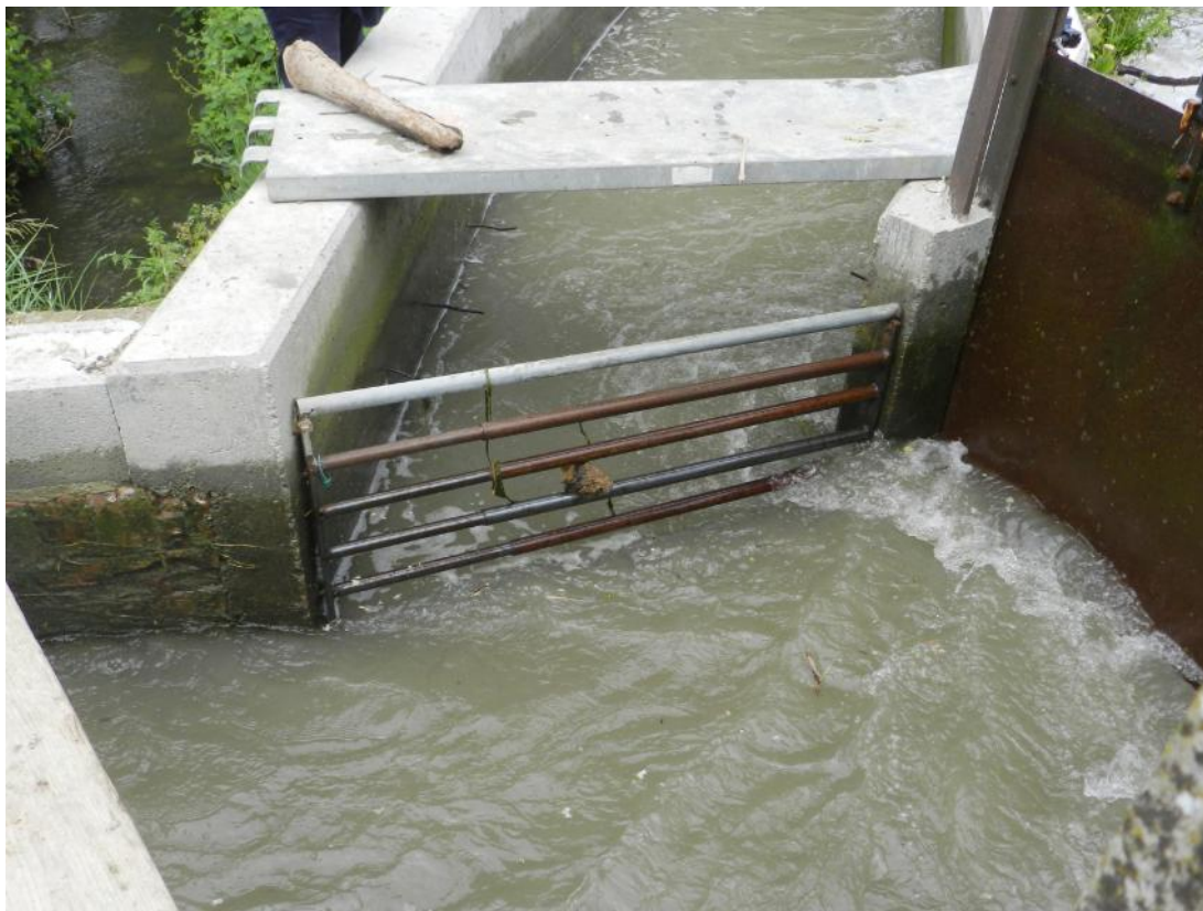
Figura 11: griglia del canale Sforza che porta alla ruota
