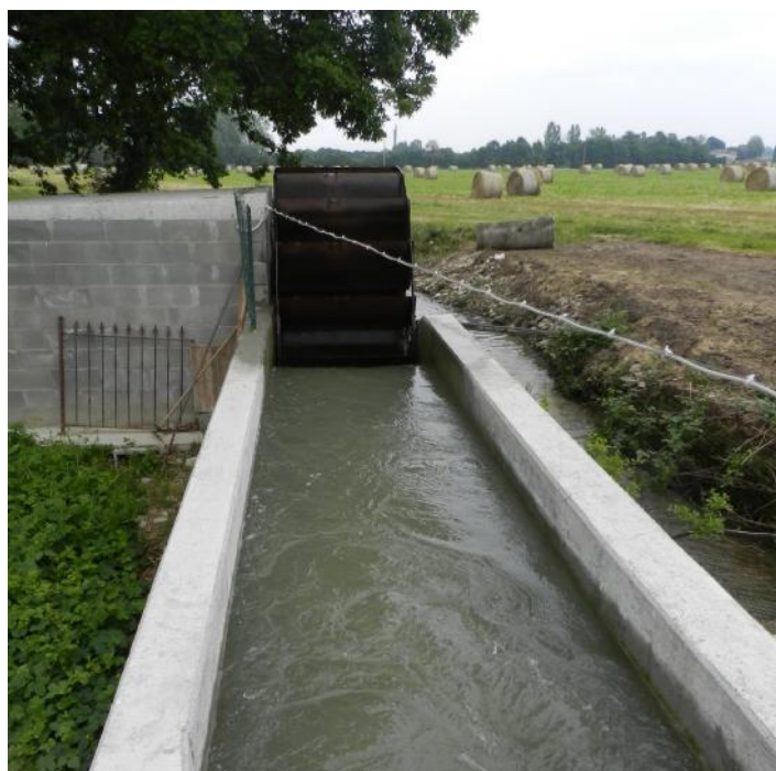
Figura 12: canale di adduzione alla ruota, esterno al canale naturale
