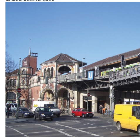
5. Stazione della S-Bahn
