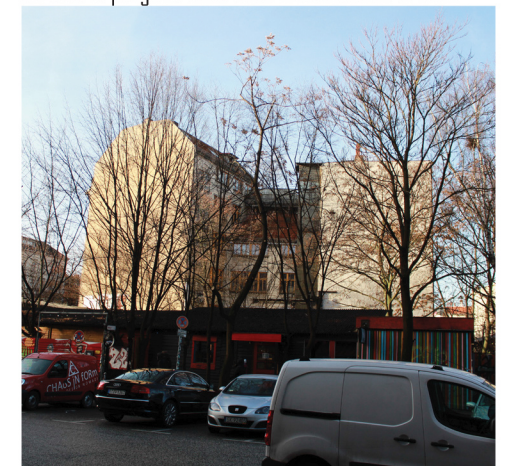
9. Edificio presente visto dalla Falckensteinstrasse
