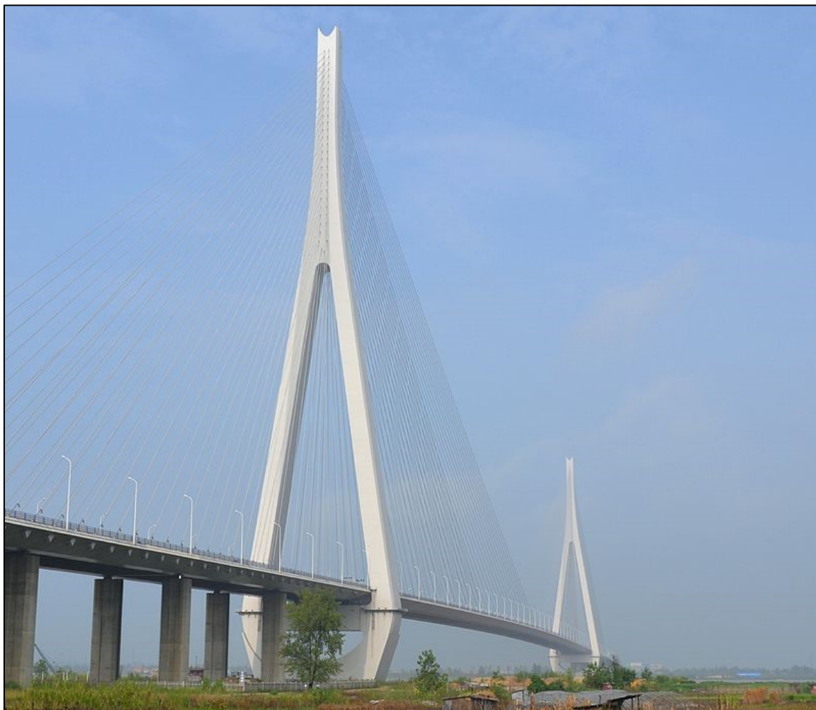
Figura 75, Edong Bridge, Huanggang, Cina; lunghezza totale 1486 m, campata massima 926 m, larghezza impalcato 33 m
