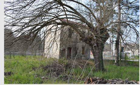
3. Vista del Casello da sud-est
